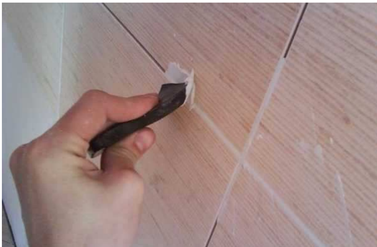
Рисунок 11 – Заделка швов фугой
