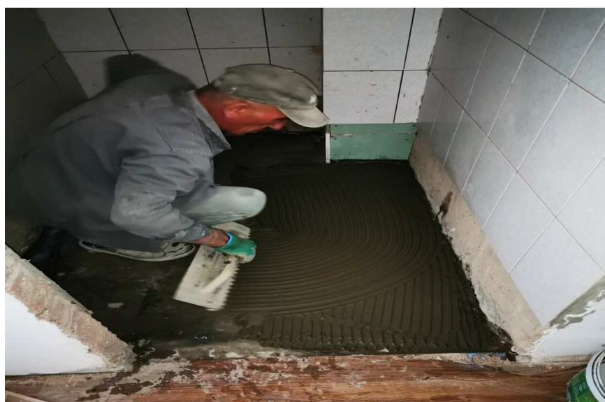
Рисунок 8 - Нанесение клеевого раствора зубчатым шпателем
