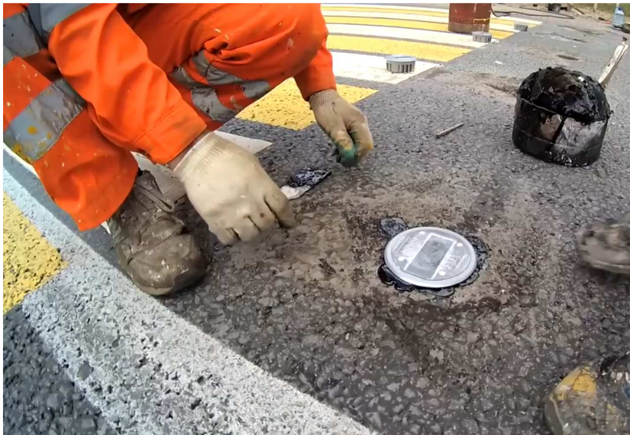
Рисунок 8 - Монтаж световозвращающего элемента (диодного модуля)
