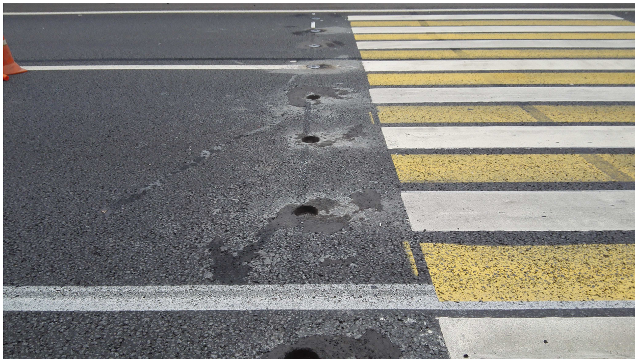
Рисунок 2 - Сверление отверстия в дорожном покрытии
