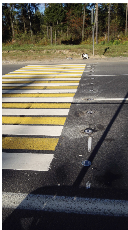
Рисунок 10 - Общий вид установленных светодиодных дорожных маркеров на солнечной батарее
