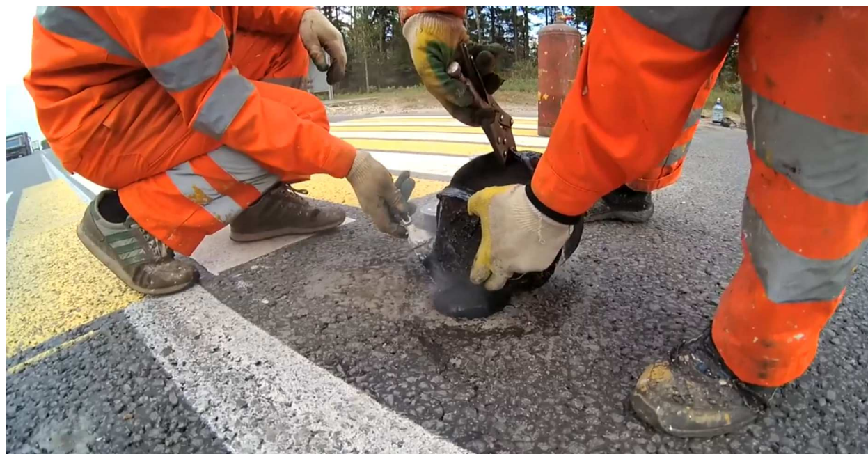
Рисунок 7- Нанесение битумного клея
