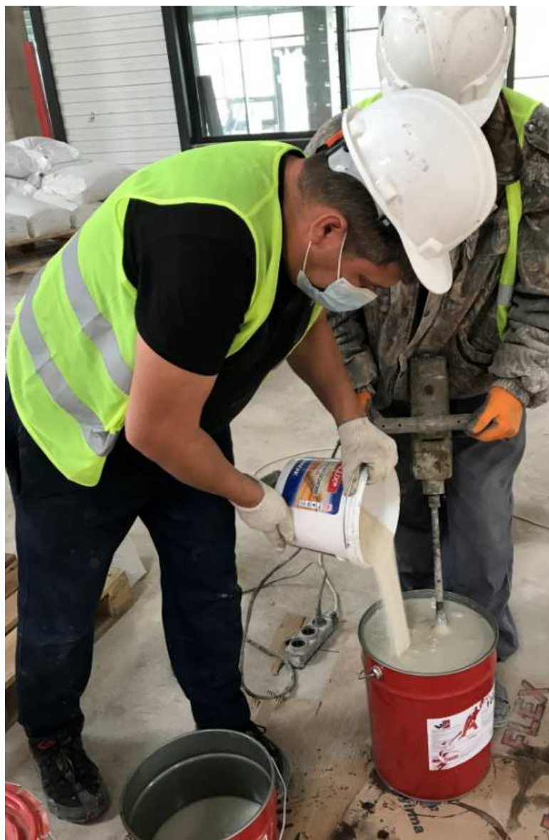
Рисунок 7 – Пример приготовления грунтовочного состава из двух компонентов с добавлением кварцевого песка
