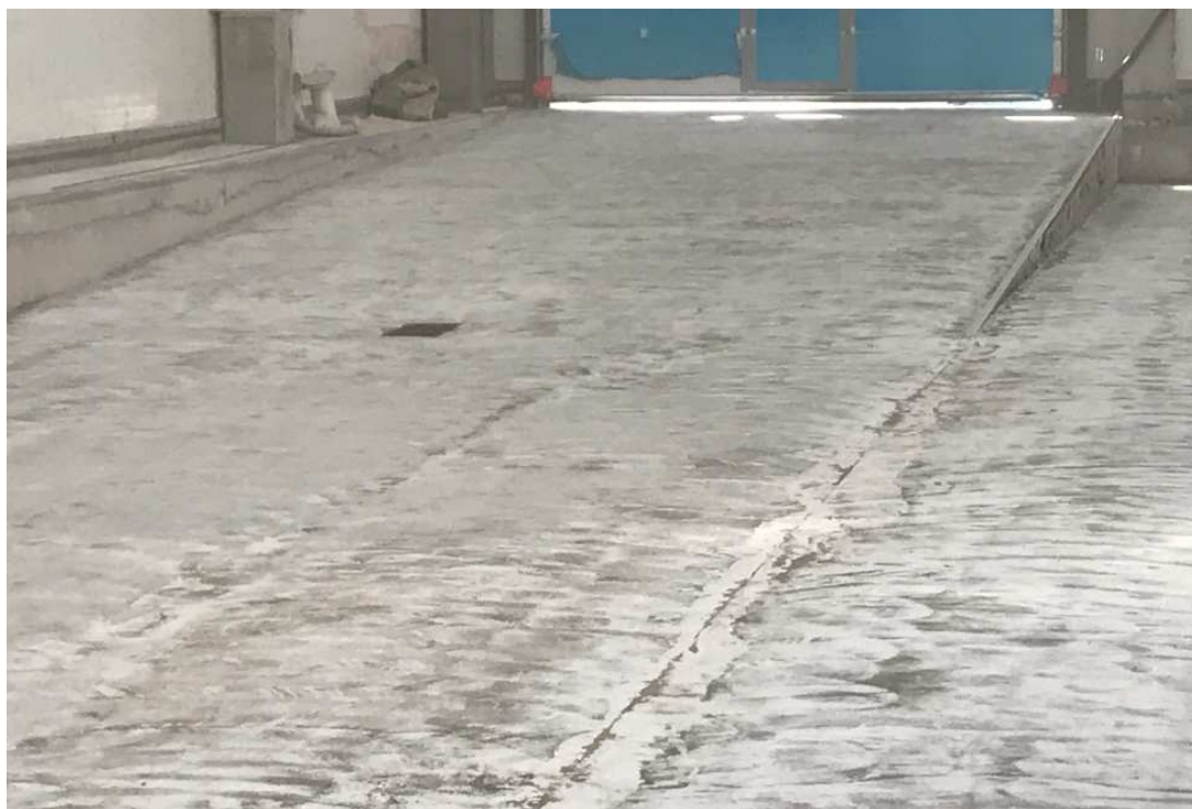
Рисунок 11 - Поверхность бетонного основания после уборки излишков песка
