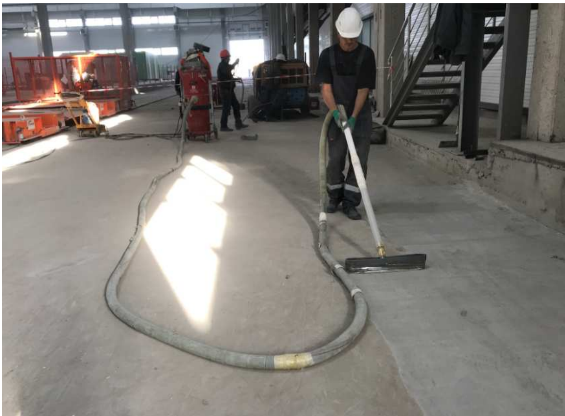
Рисунок 9 - Общий вид очистки и обеспыливания бетонного основания строительным пылесосом
