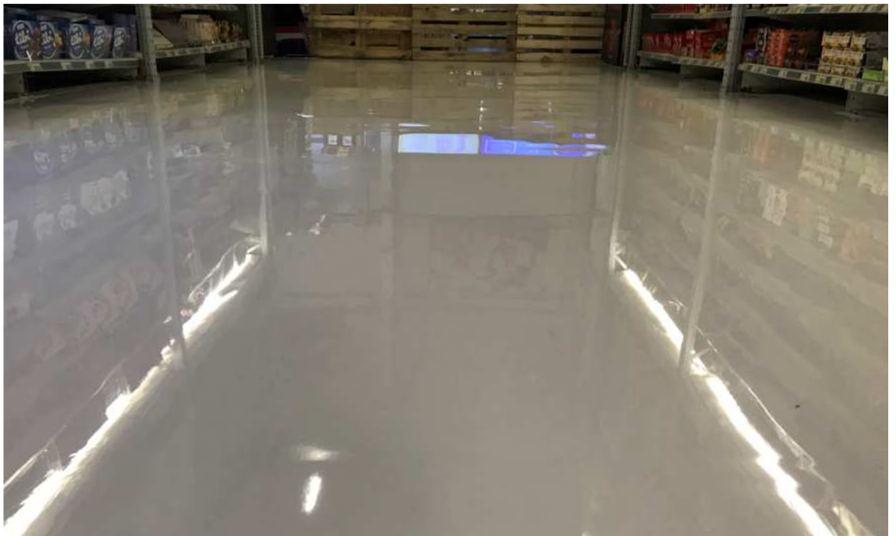
Рисунок 14 – Процесс нанесения и приготовления финишной наливной композиции
