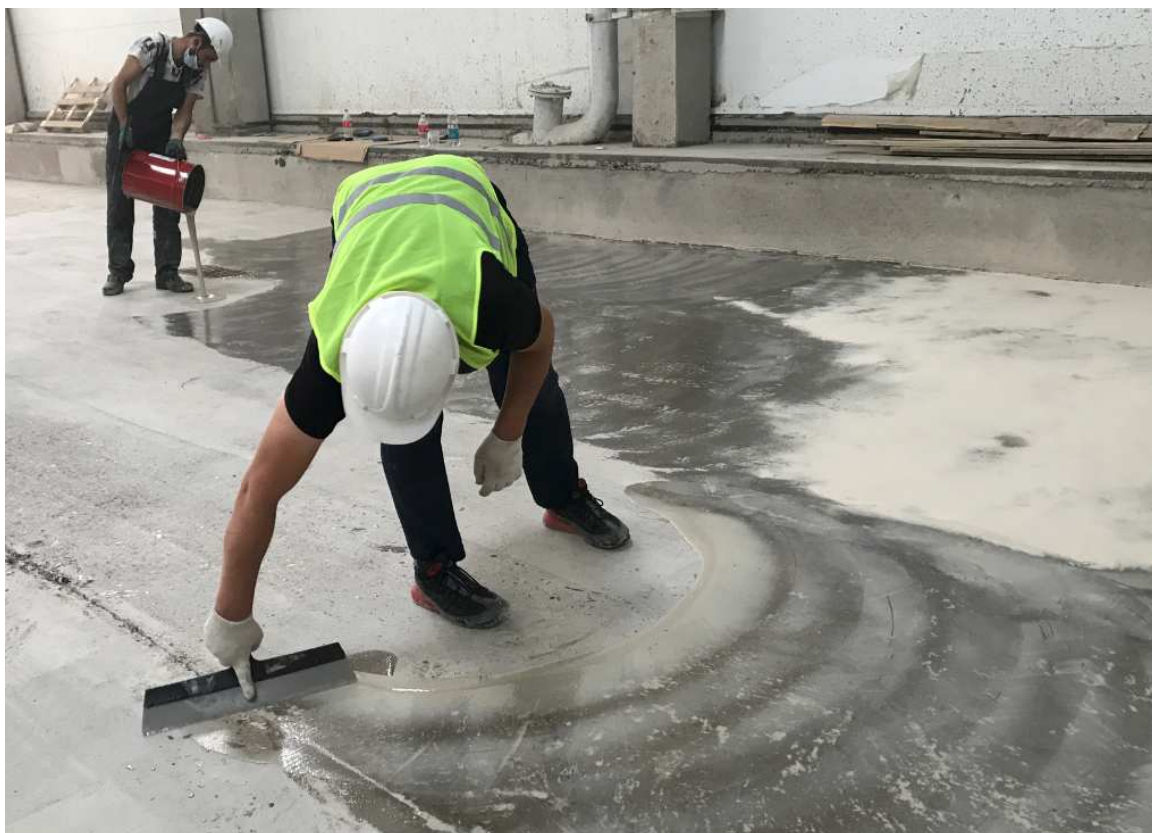
Рисунок 10 - Нанесение грунтовочного состава с кварцевым песком
