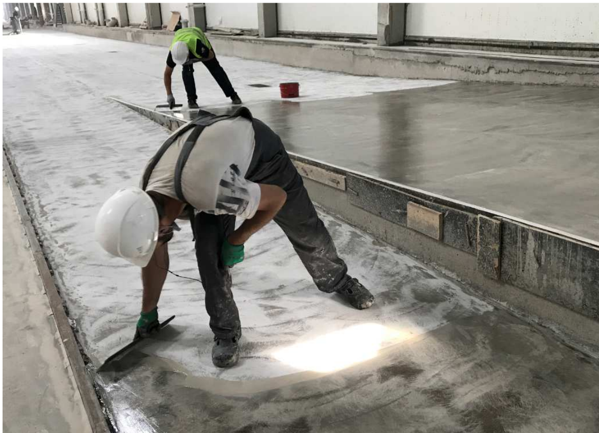
Рисунок 13 – Нанесение второго слоя грунтовки (запечатка)
