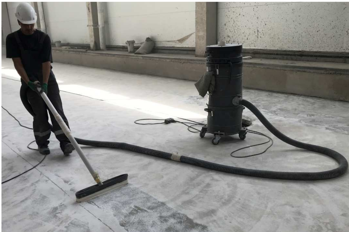
Рисунок 12 - Обеспыливание бетонного основания строительным пылесосом перед нанесением второго слоя грунтовки (запечатка)
