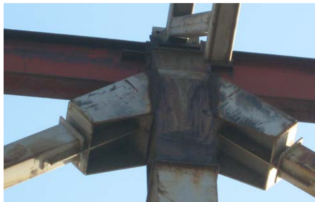
А.25 сурет – Жылжымалы энергияны сіңіргішпен тіректі байланысты
