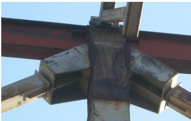
Рисунок А.25 – Раскосная связь со сдвиговым энергопоглотителем
