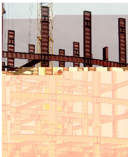
Рисунок А.4 – Фрагмент рамного каркаса стального сейсмостойкого здания с двутавровыми колоннами и ригелями с поперечно гофрированными стенками
