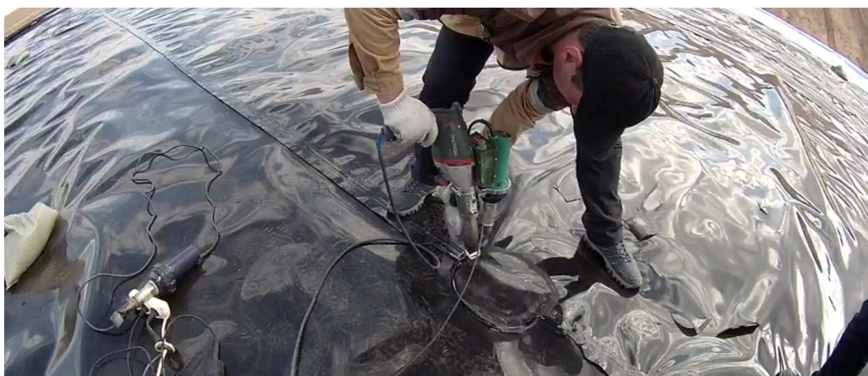
Рисунок 8 - Процесс экструзионной сварки
