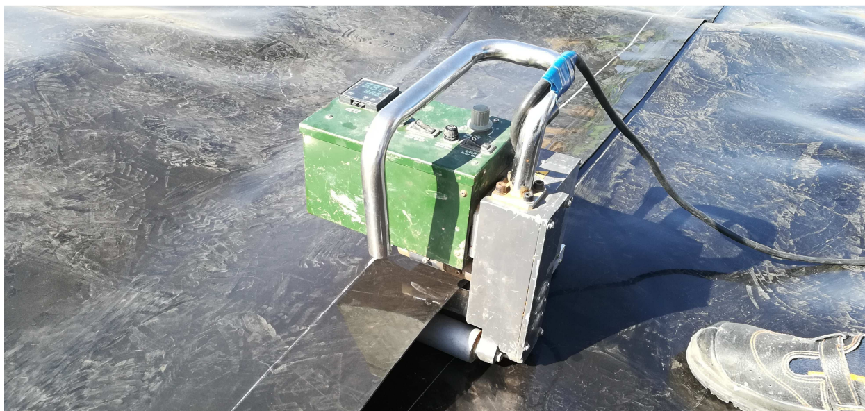
Рисунок 6 - Сварка геомембраны контактной сваркой
