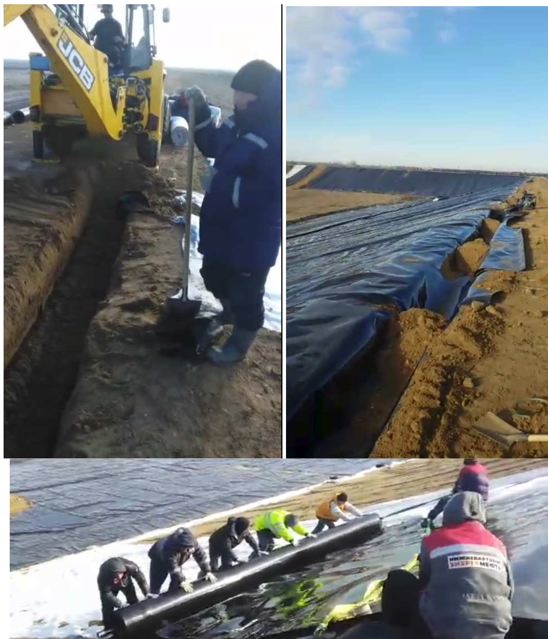
Рисунок 5 - Укладка рулонов геомембран на откосах котлована
