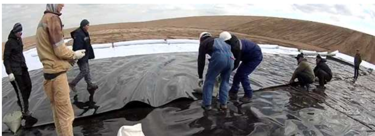
Рисунок 4 - Укладка рулонов геомембран по основанию котлована
