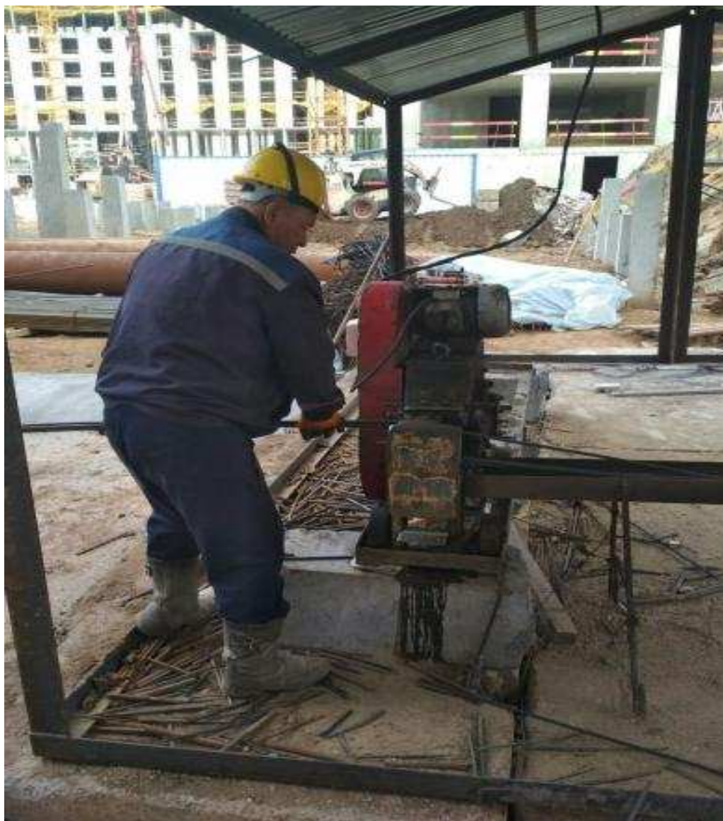
Рисунок 5 – Резка арматуры на приводном станке
