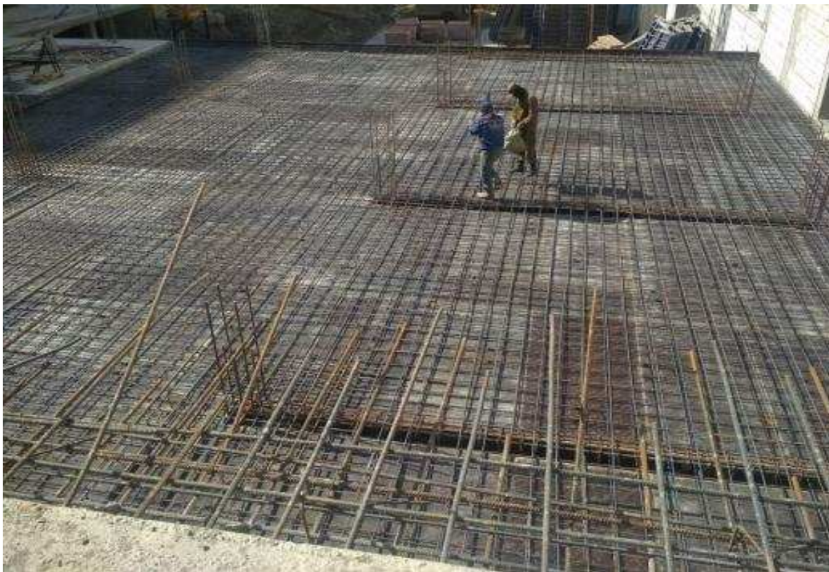
Рисунок 8 – Устройства монолитной железобетонной плиты перекрытия толщиной 250 мм
