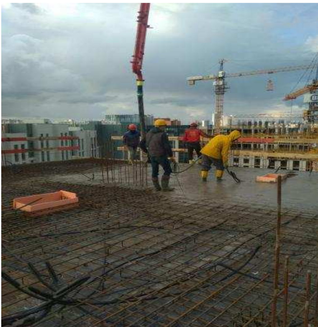
Рисунок 9 - Укладка и уплотнение бетонной смеси
