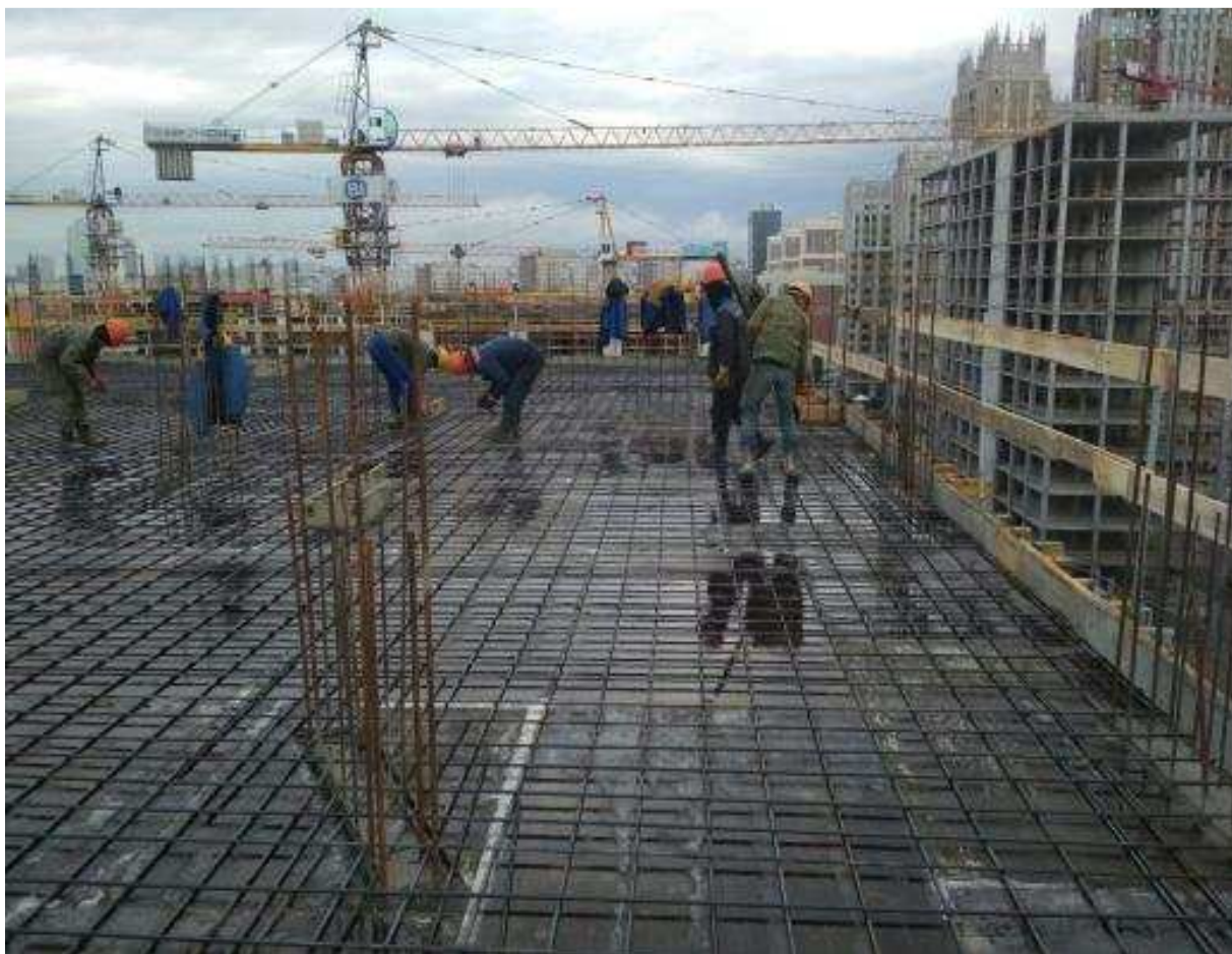
Рисунок 7 – Устройства монолитной железобетонной плиты перекрытия толщиной 200 мм
