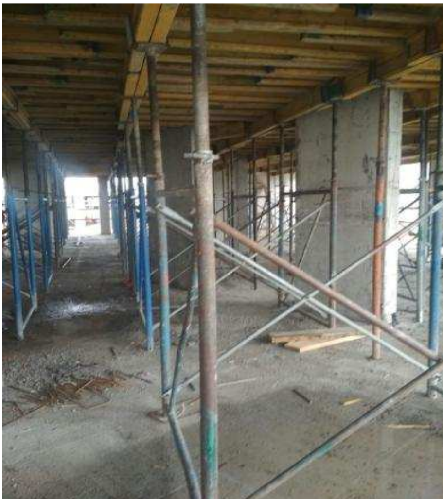
Рисунок 3 – Установка опалубки плиты перекрытия на основе опорных башен
