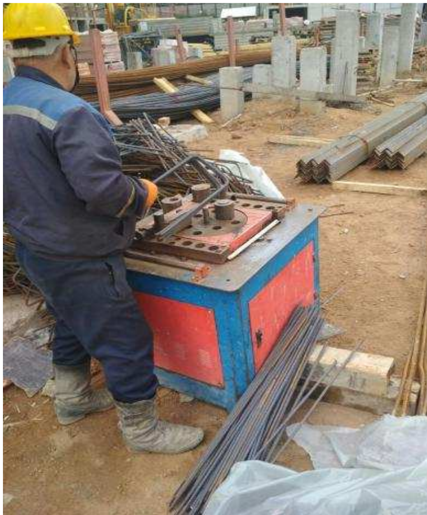
Рисунок 6 – Гнутье арматуры на приводном станке
