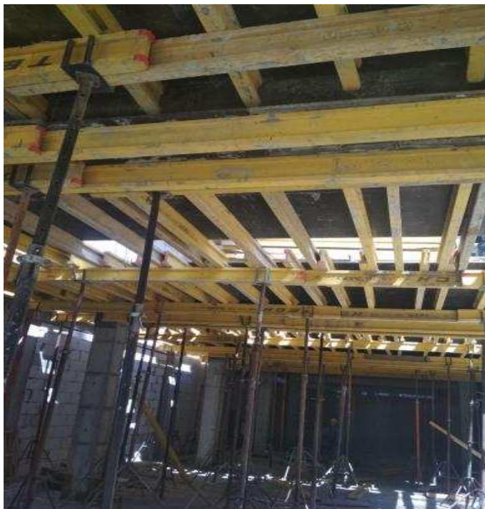
Рисунок 4 – Установка опалубки плиты перекрытия на основе телескопических стоек
