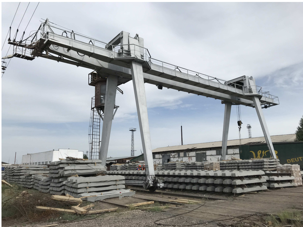
Рисунок 6 – Общий вид козлового крана грузоподъемностью 12 тонн
