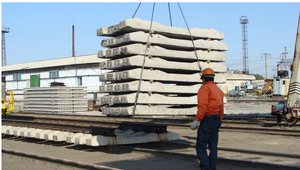
Рисунок 2 – Строповка железобетонных шпал
