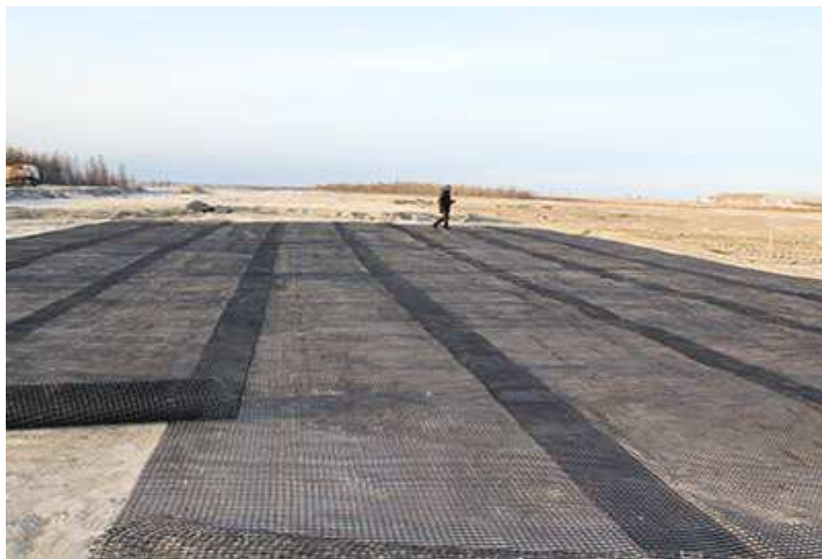
Рисунок 10 – Раскатка рулона геосетки
