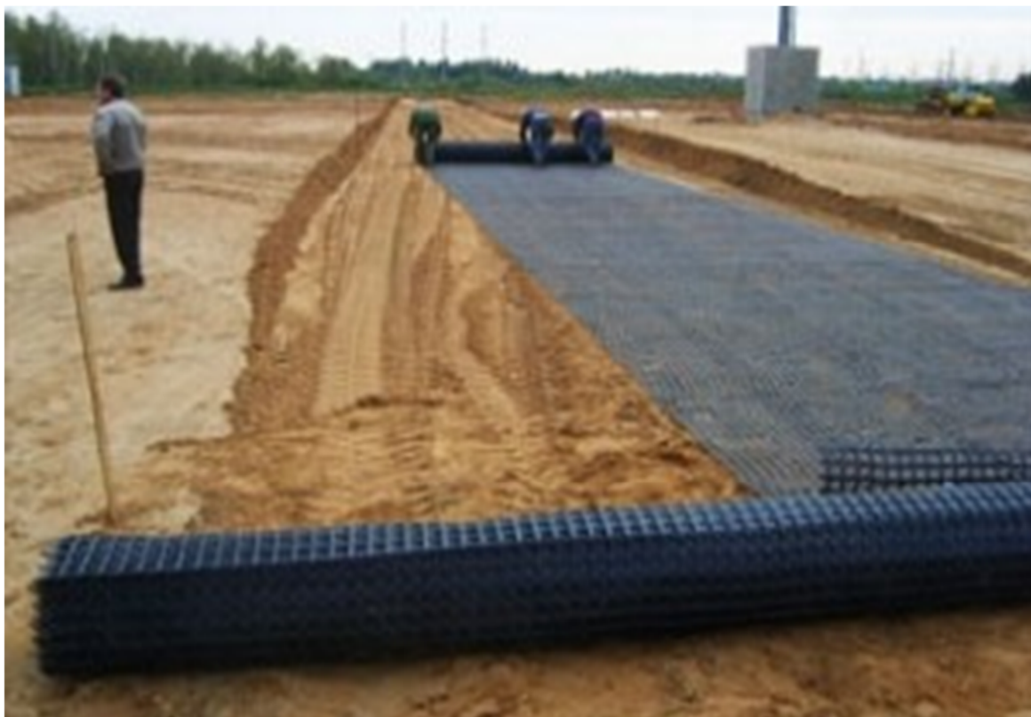
Рисунок 10 – Раскатка рулона геосетки
