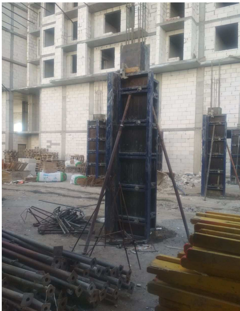
Рисунок 6 – Установка опалубки колонн
