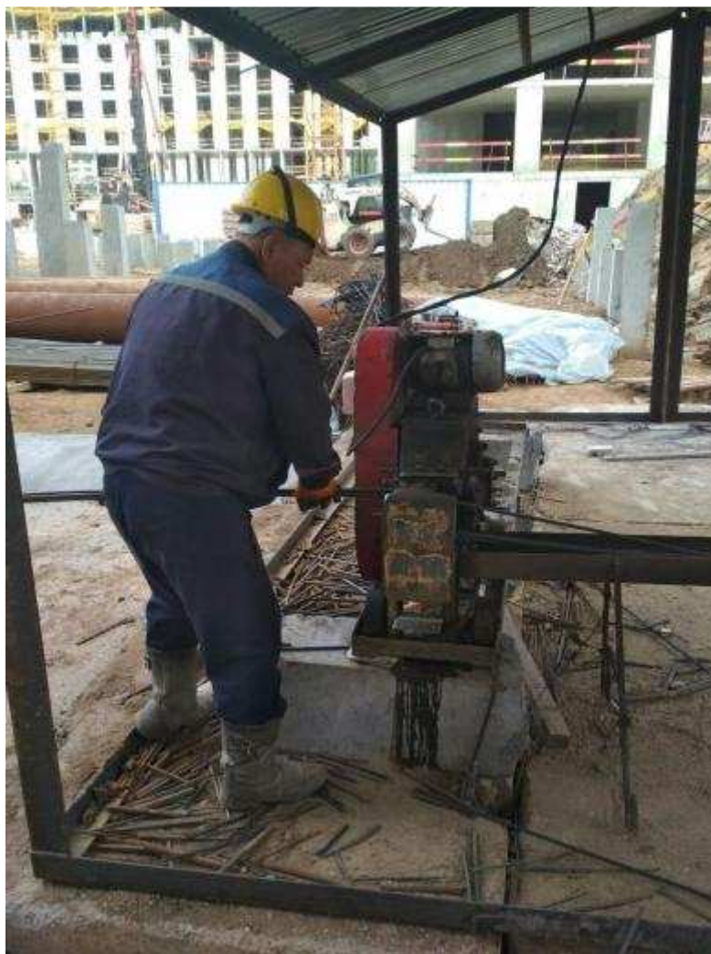
Рисунок 2 – Резка арматуры на приводном танке
