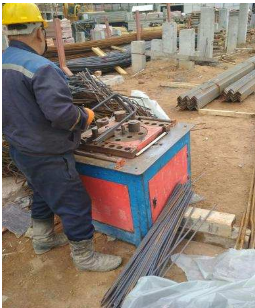
Рисунок 3 – Гнутье арматуры на приводном станке
