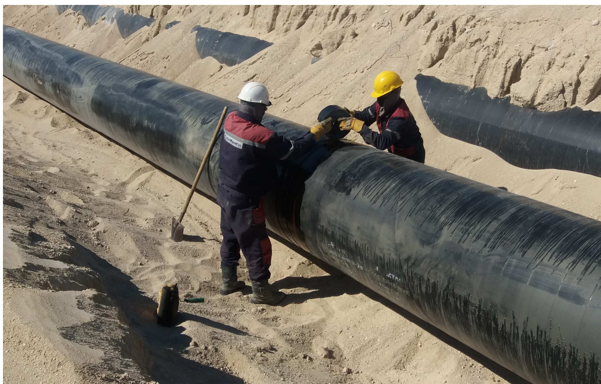
Рисунок 9 – Процесс наматывания полимерной ленты на огрунтованный сварной стык трубопровода
