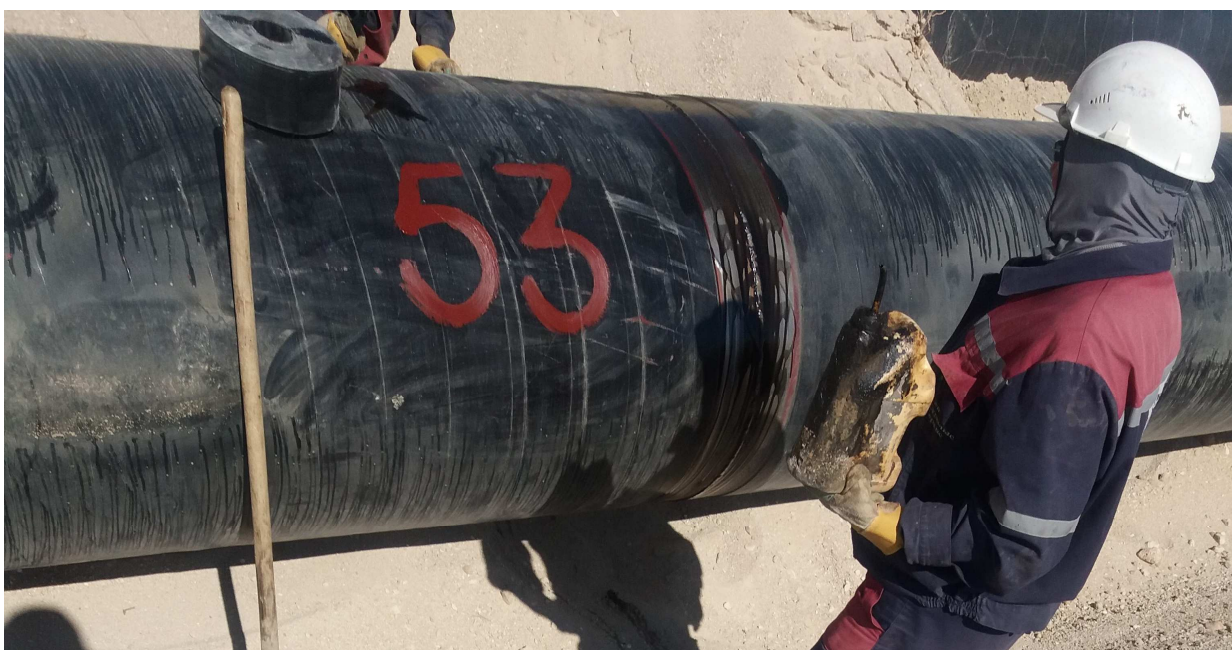
Рисунок 7 – Нанесение праймера на сварной стык трубопровода
