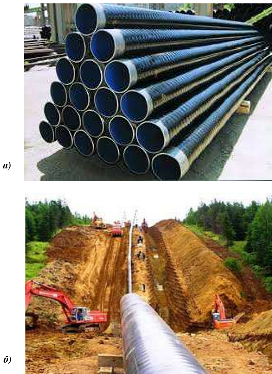
Рисунок 4 – Плеть из изолированных труб на притраншейной площадке
