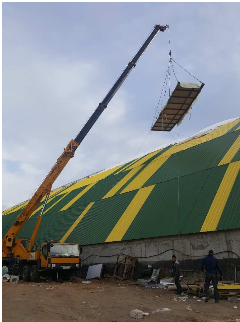
Рисунок 8 - Общий вид автокрана с монтажной платформой
