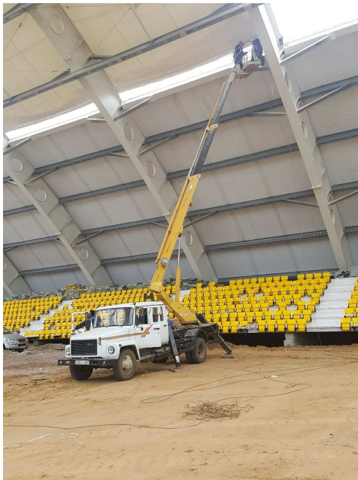
Рисунок 4 - Монтаж блока с роликом для помощи в растяжке мембраны
