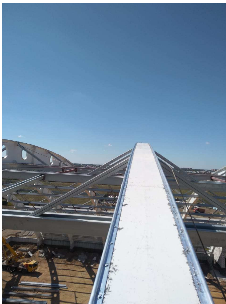
Рисунок 6 - Общий вид смонтированной направляющей
