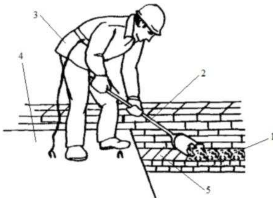
Рисунок 9 – Подготовка растворной постели
