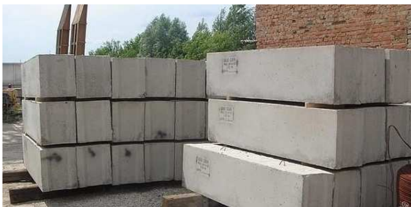
Рисунок 4 - Общий вид складирования фундаментных блоков
