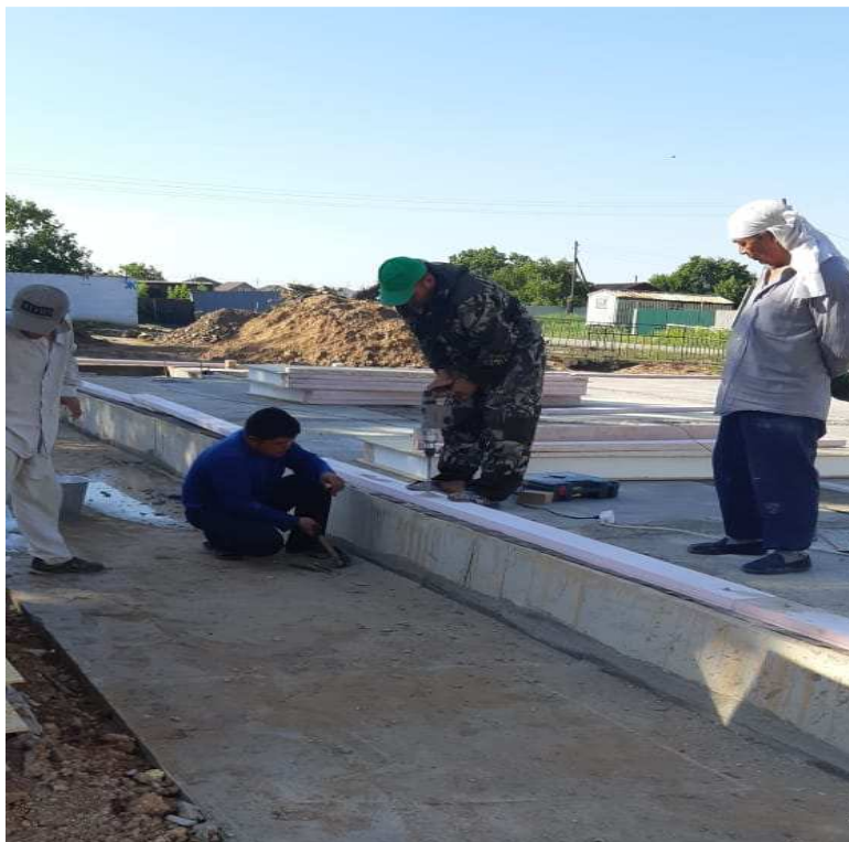
Рисунок 6 – Установка нижней обвязки стен
