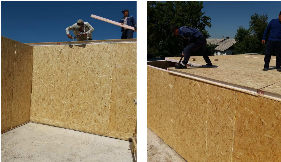
Рисунок 11 - Монтаж перекрытия из СИП панелей
