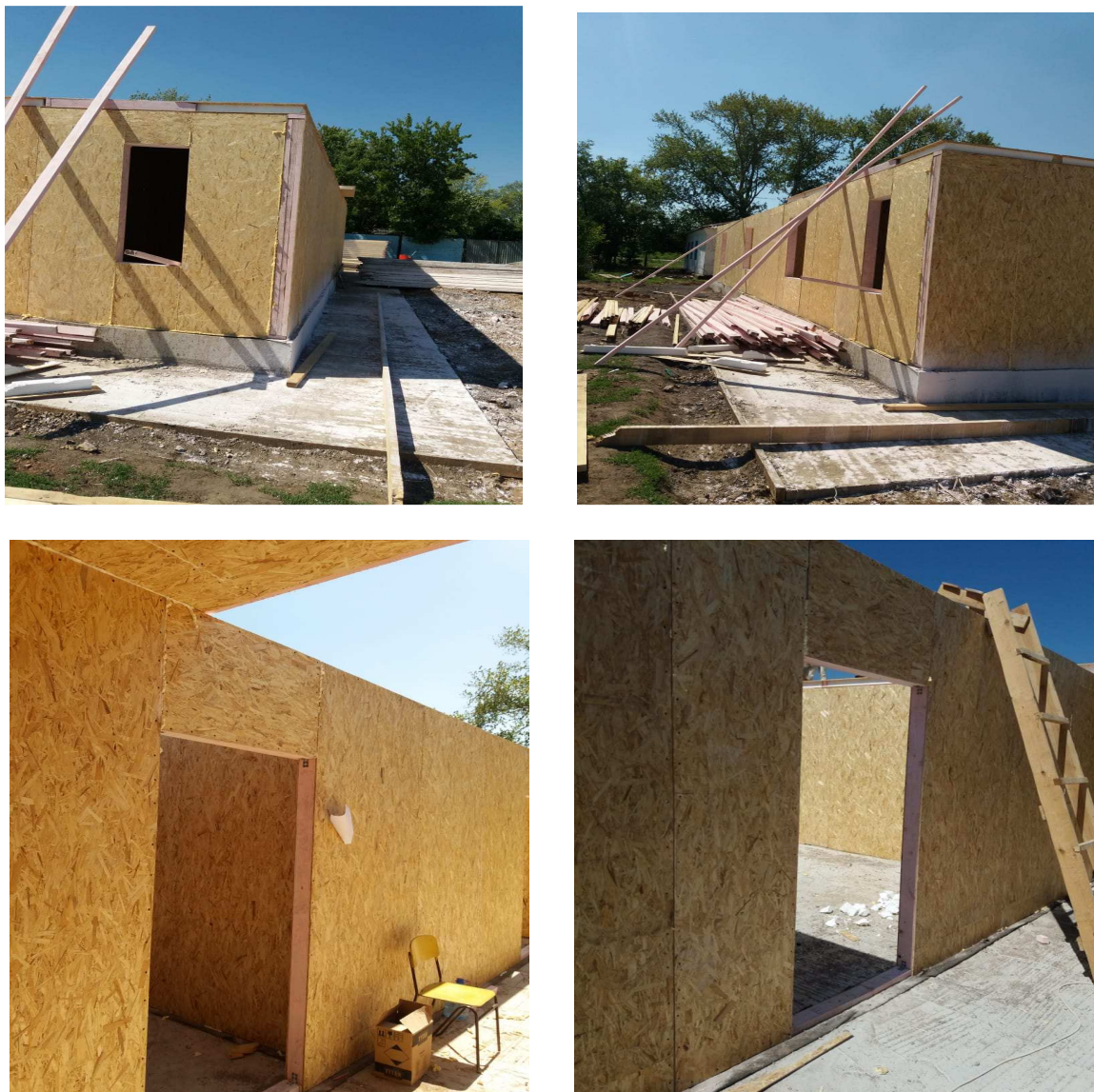
Рисунок 7 – Монтаж стен из СИП панелей
