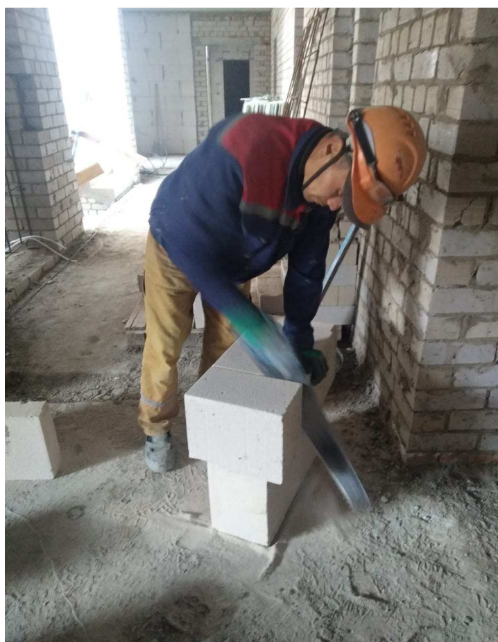
Рисунок 11 – Подрезка блока
