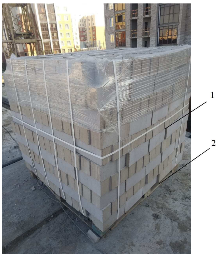
Рисунок 5 - Схема складирования кирпича 1 - кирпич ГОСТ 3799-2015; 2- поддон ГОСТ 18343-80
