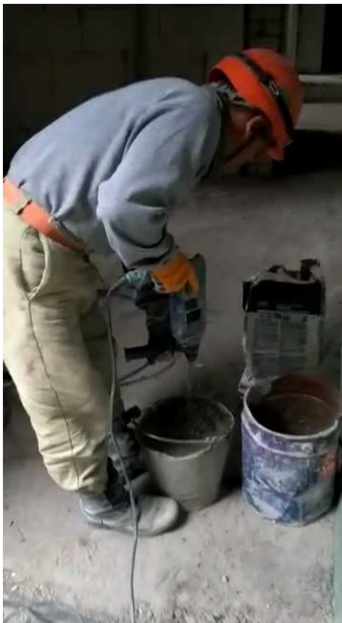
Рисунок 14 - Приготовление клеевой смеси
