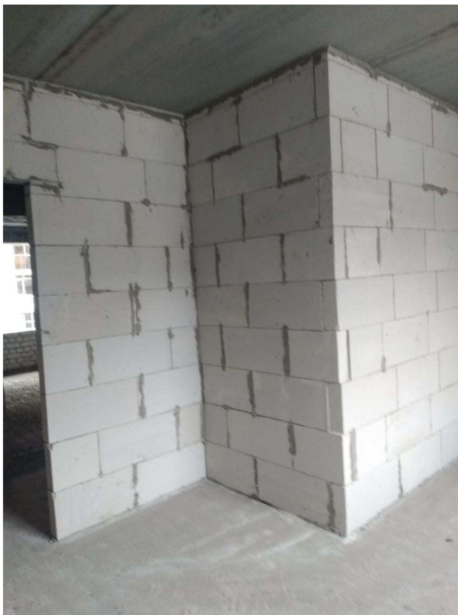
Рисунок 12 – Возведенная перегородка
