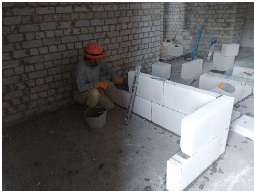
Рисунок 10 - Возведение кладки из газоблока
