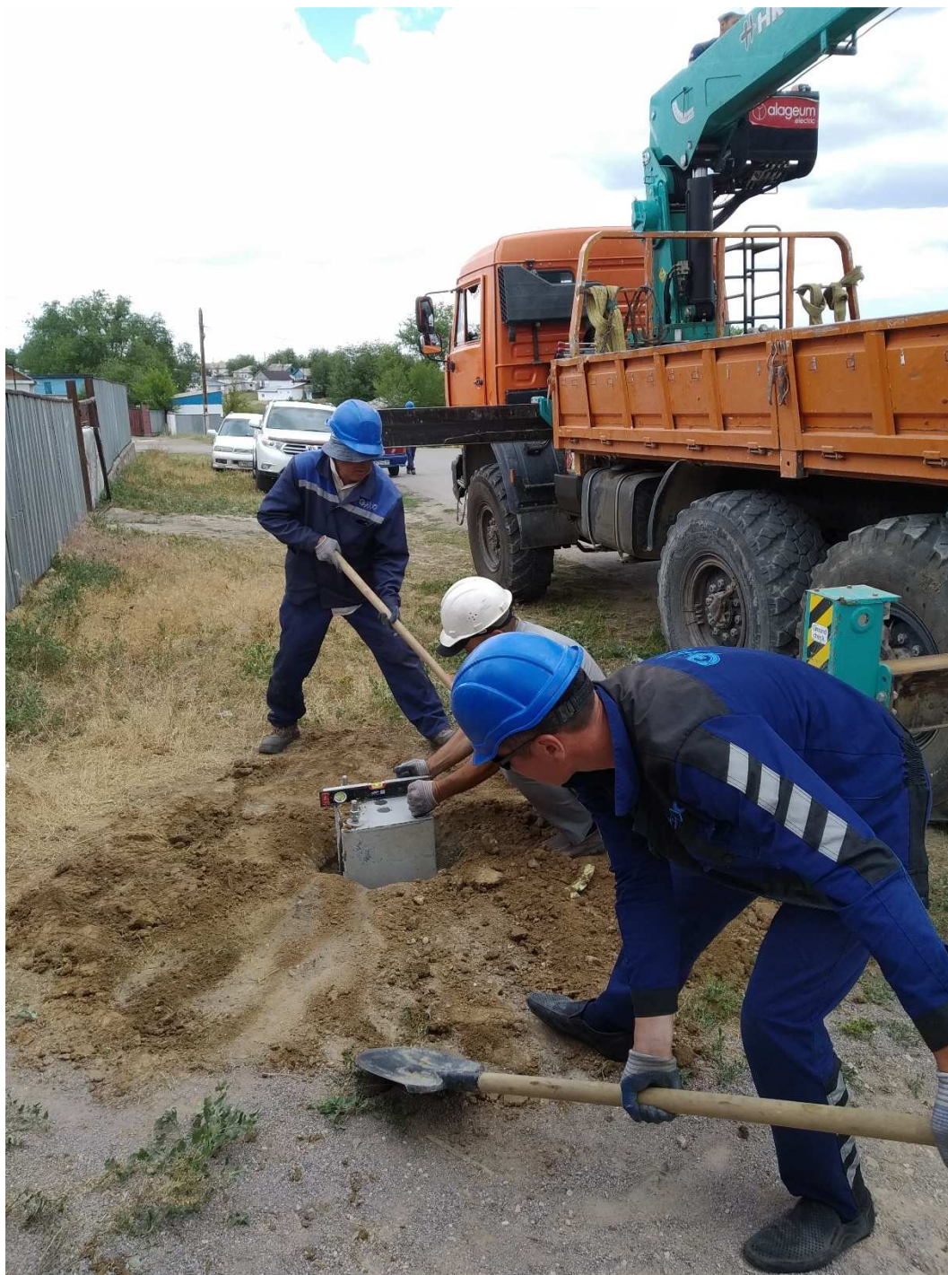
Рисунок 16 – Установка фундамента опоры освещения
