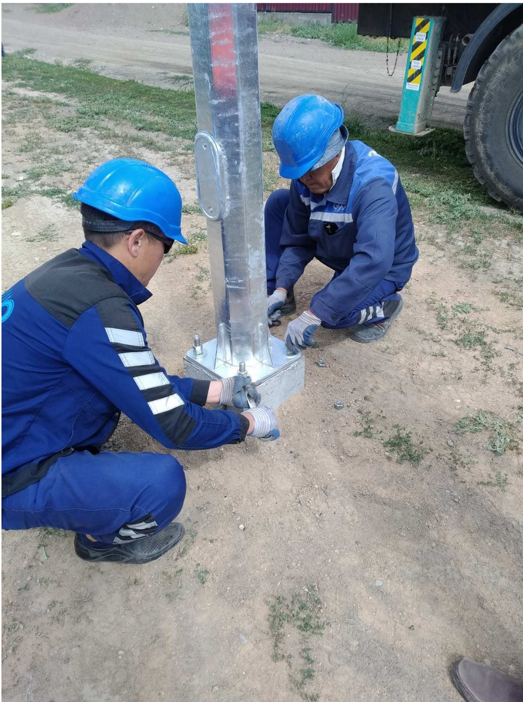
Рисунок 17 – Установка опоры освещения
