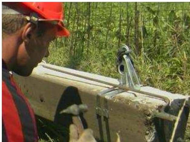
Рисунок 52 - Установка крепежных кронштейнов к опоре.
