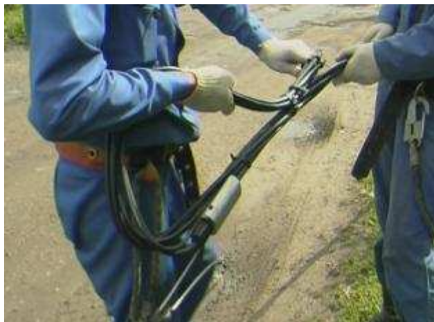
Рисунок 58 – Жгут провода, для крепления к анкерной опоре.
