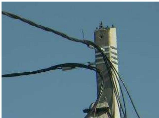
Рисунок 61 - Несущая нулевая жила отделяется от фазных с помощью отделительных клиньев, вкладывается в углубление поддерживающего зажима и крепится фиксатором.
