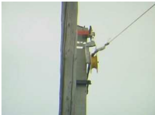
Рисунок 57 - Крепление раскаточного ролика с крюком на промежуточной опоре.
