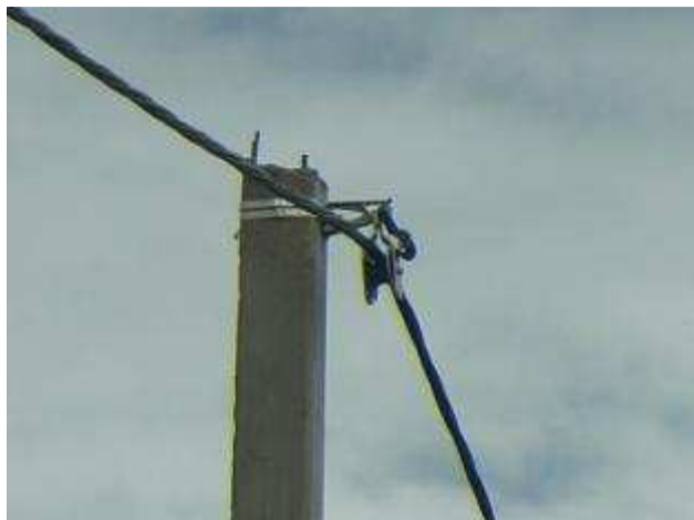
Рисунок 60 - На промежуточной опоре в поддерживающий зажим с раскаточного ролика переключается СИП.
