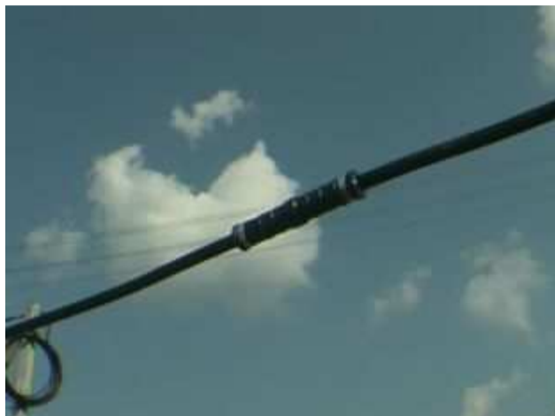
Рисунок 62 - Применяются герметичные соединительные изолированные зажимы.
