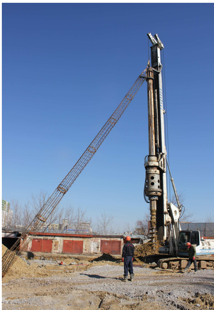
а - подведение арматурного каркаса к обсадной трубе; б - установка арматурного каркаса в обсадную трубу;
