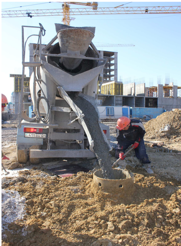
Рисунок 15 - Процесс бетонирования скважины
