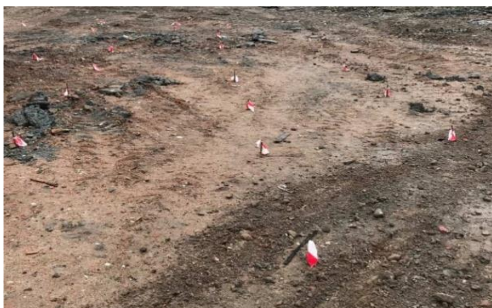
Рисунок 14 – Общий вид выноса осей свай в натуре и маркировка
