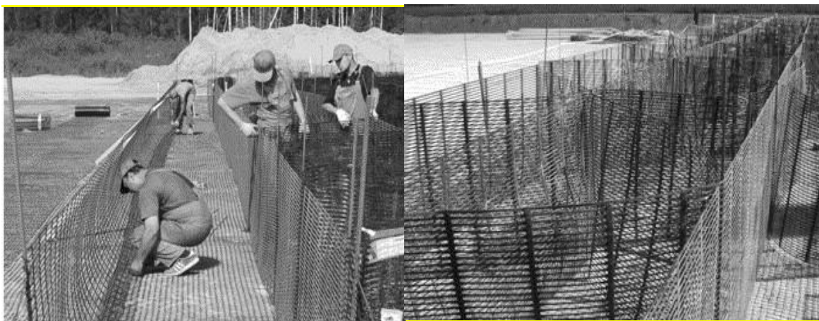
38-сурет-Диагональды тік элементтерді монтаждау
