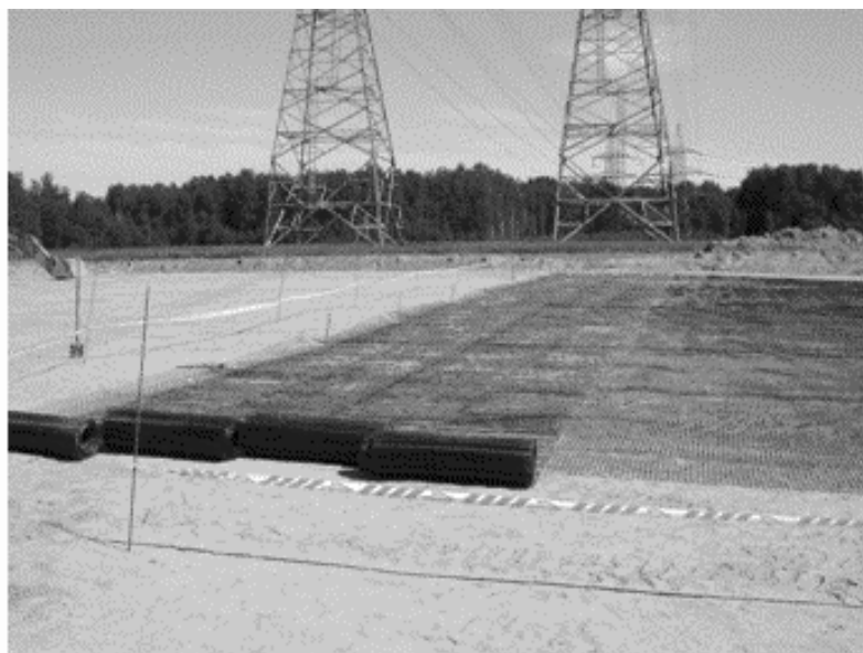
Рисунок 36 - Укладка одноосной георешетки
