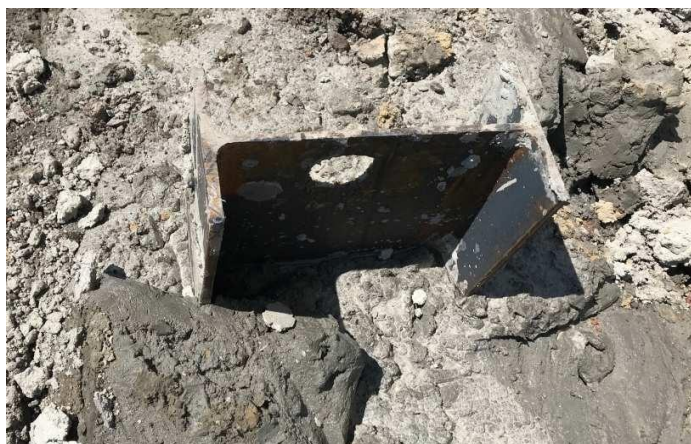
15 - сурет – Топырақ цементті қадаларда құрастырылған батырылған қаңқа
