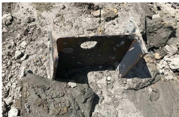
Рисунок 15 – Погруженный каркас в разработанный грунтоцементный свай
