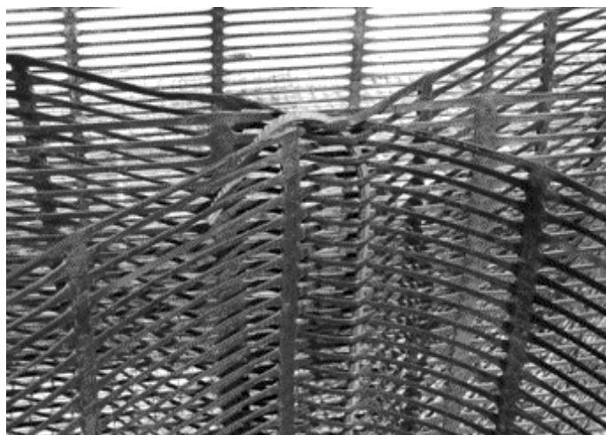
Рисунок 39 - Узловое соединение диагональных диафрагм и поперечных георешеток
