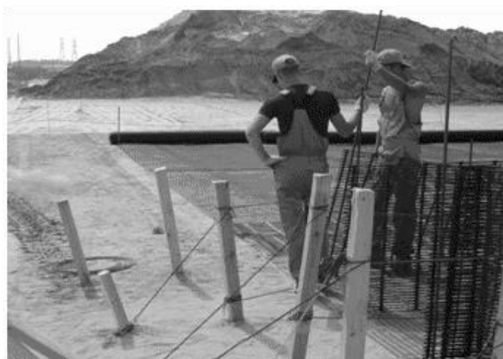
Рисунок 37 - Подъем, натяжение и закрепление вертикальных поперечных конструкций
