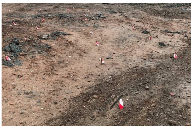
14 – сурет – Бағаналардың осьтерін натураға шығарудың жалпы түрі және таңбалау
