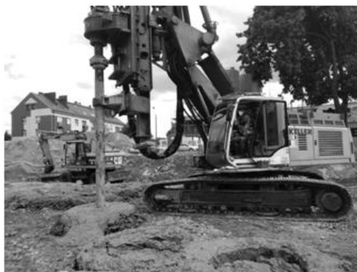
Рисунок 16 – Процесс устройства грунтоцементных свай
