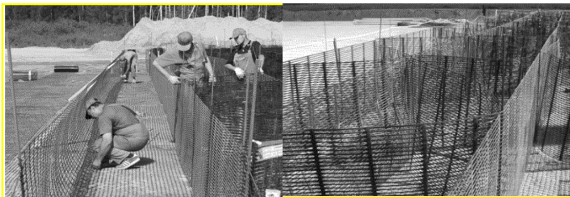
Рисунок 38 - Монтаж диагональных вертикальных элементов
