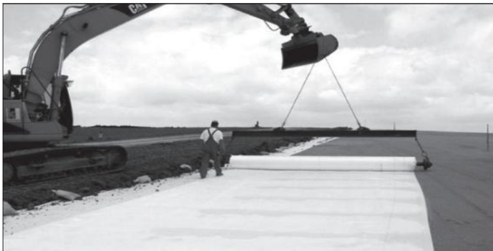
42-сурет – Эскаватор шөмішіндегі аспаны қолдана отырып геотоқыманы төсеу
