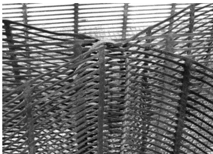
39-сурет - Диагональды диафрагмалар мен көлденең геoshарбақтардың түйіндік байланысы
