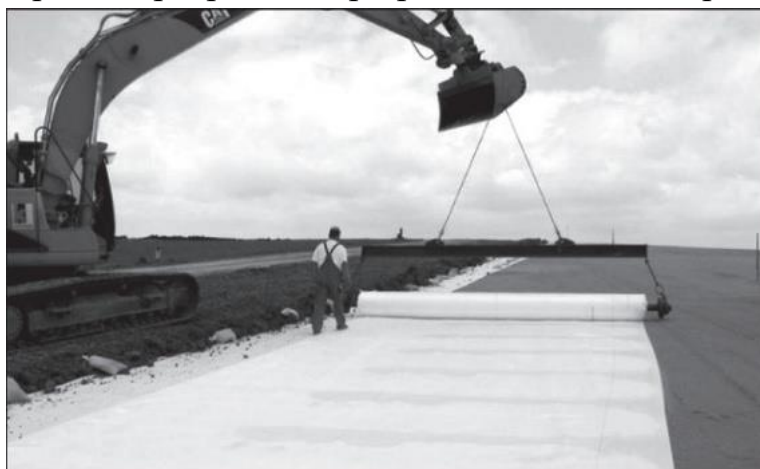
Рисунок 42 – Укладка геотекстиля с применением подвеса на ковше экскаватора
