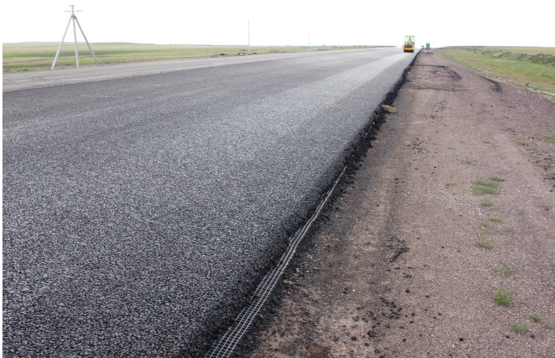
Рисунок 9 - Уложенный армирующий слой на дорожном полотне
