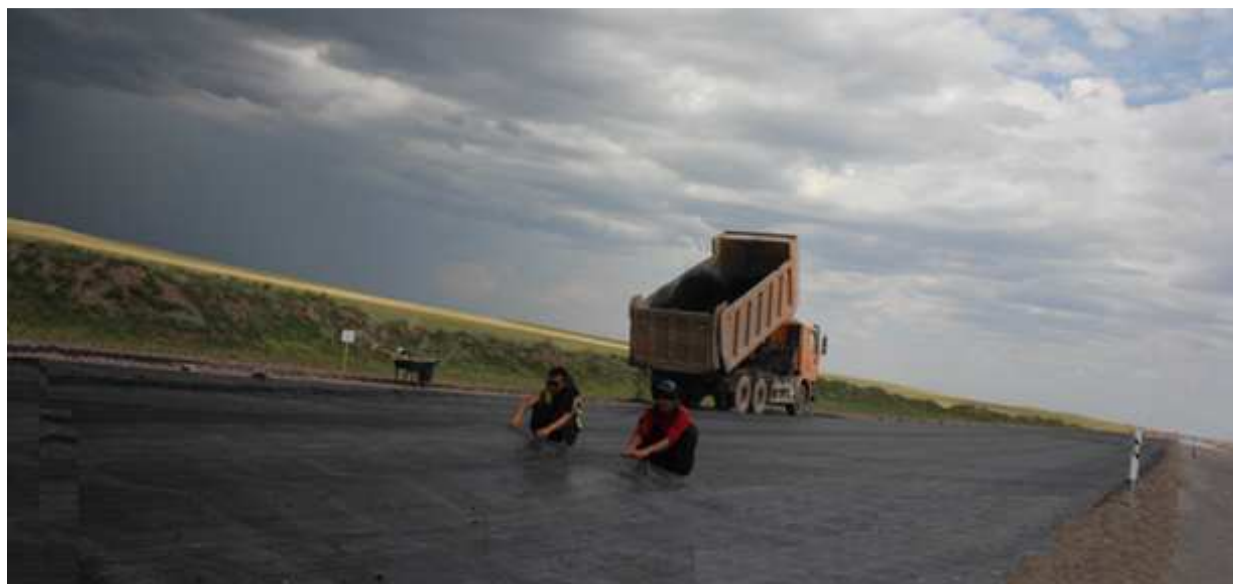
Рисунок 8 - Натяжение геосетки на дорожном полотне
