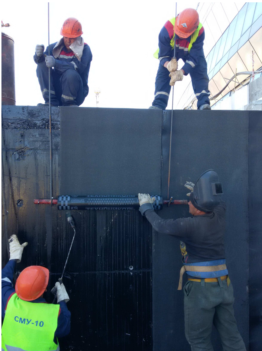
Рисунок 8 - Устройство оклеечной гидроизоляции стен
