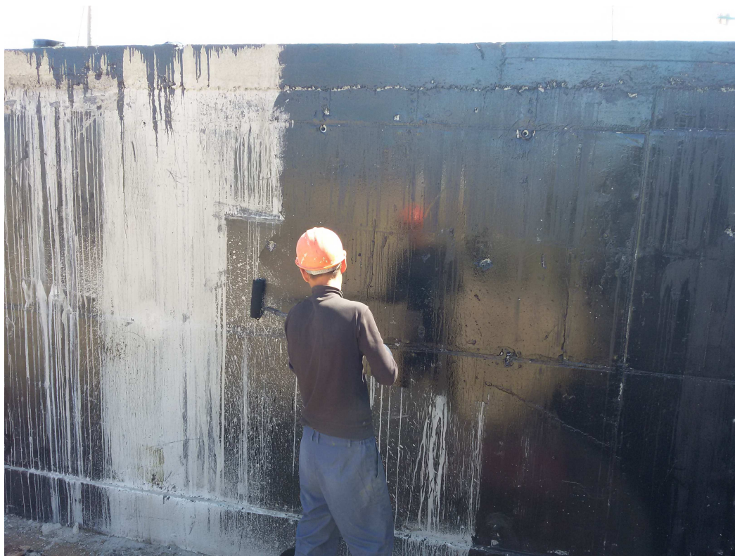
Рисунок 7 - Нанесение на поверхность стены битумного праймера
