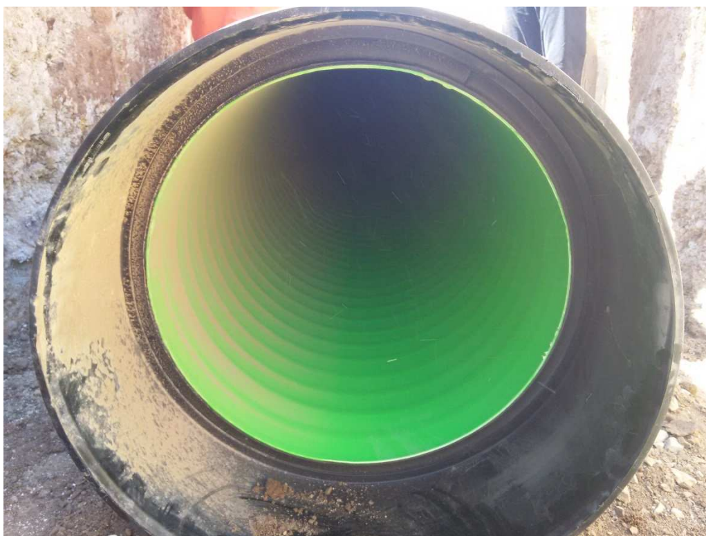
Рисунок 9 - Соединение трубопровода
