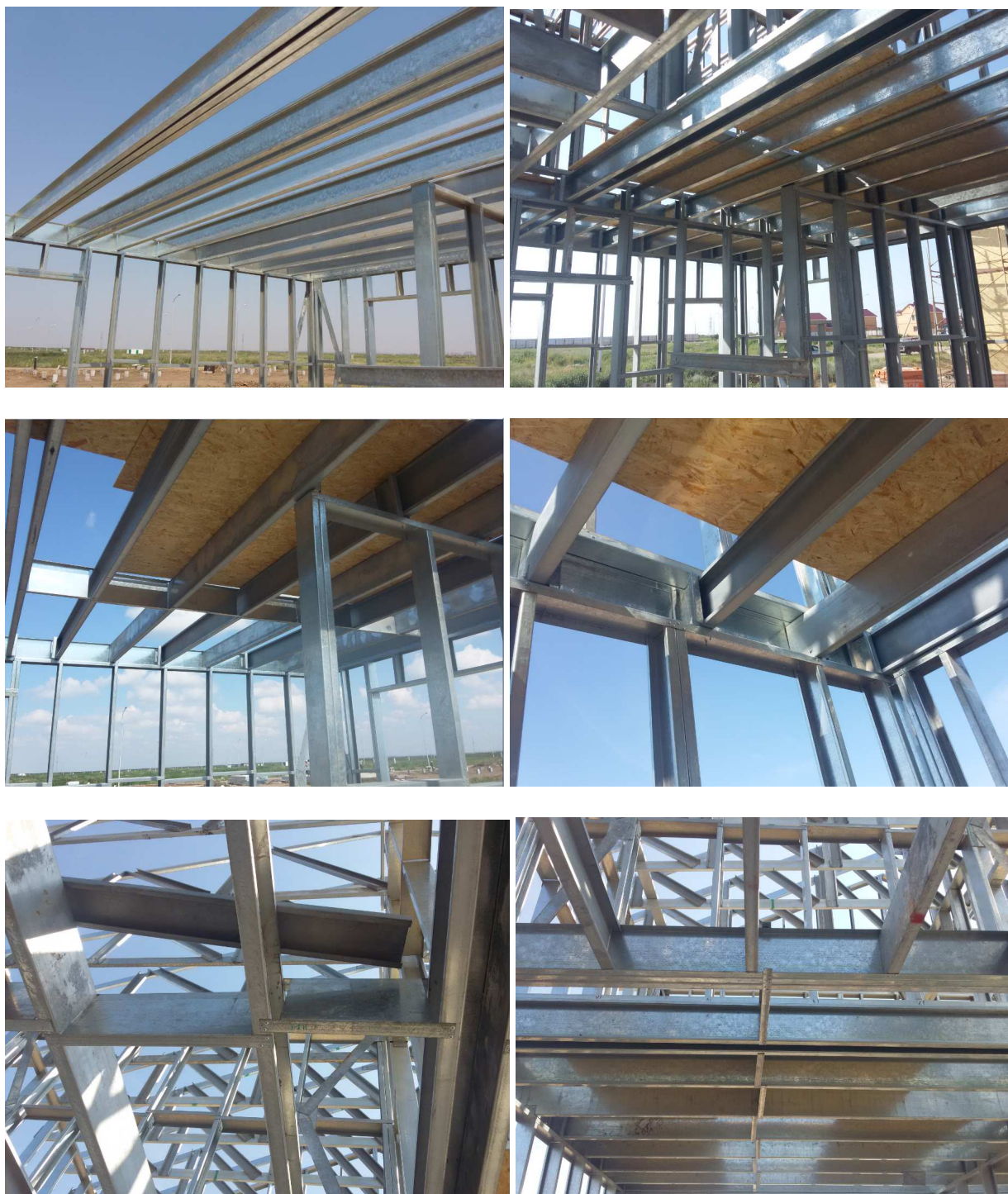
Рисунок 21 - Фрагменты крепления и связей каркаса стен с балками перекрытия
