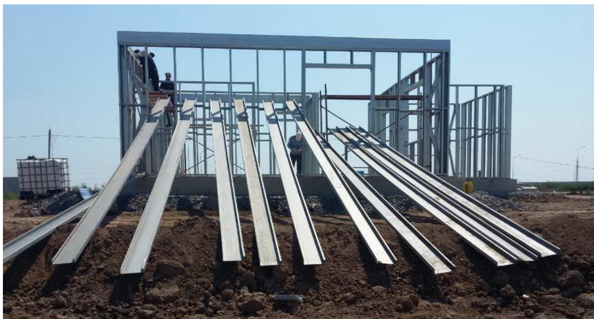
Рисунок 20 - Монтаж каркаса перекрытия из легких стальных тонкостенных конструкций (ЛСТК)
