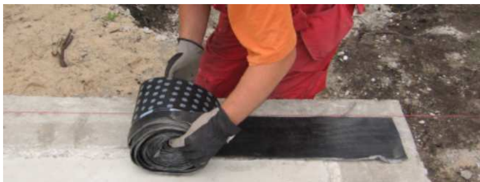
Рисунок 12 - Гидроизоляция мест сопряжения каркаса стен с фундаментом
