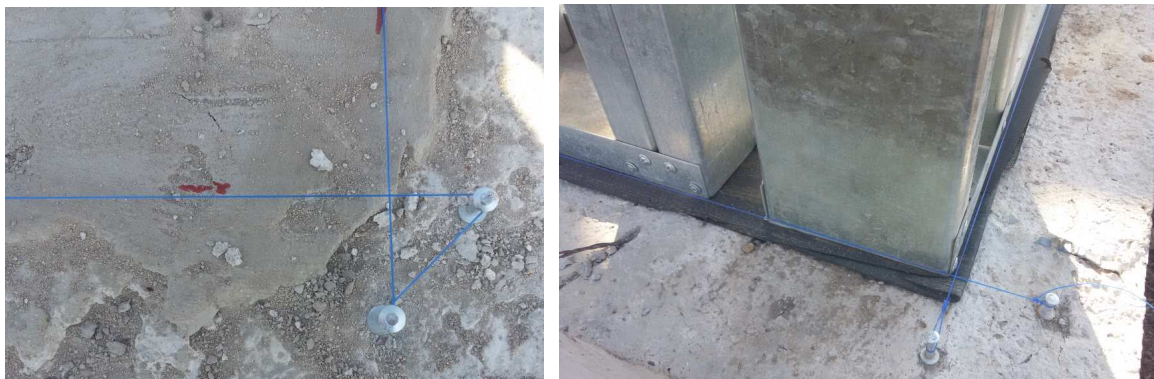
Рисунок 11 – Разметка линий монтируемых каркасов стен на фундаменте
