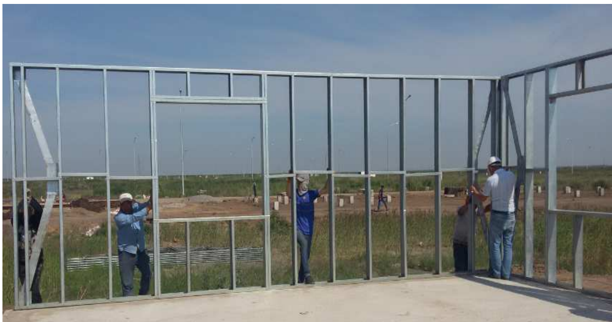
Рисунок 15 – Монтаж каркасов стен
