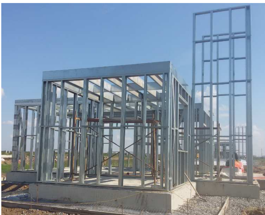
Рисунок 16 – Смонтированный каркас стен первого уровня
