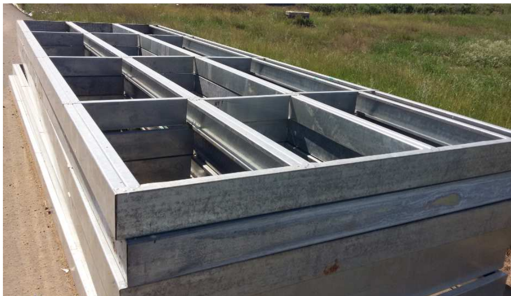
Рисунок 14 – Общий вид складированных каркасов стен
