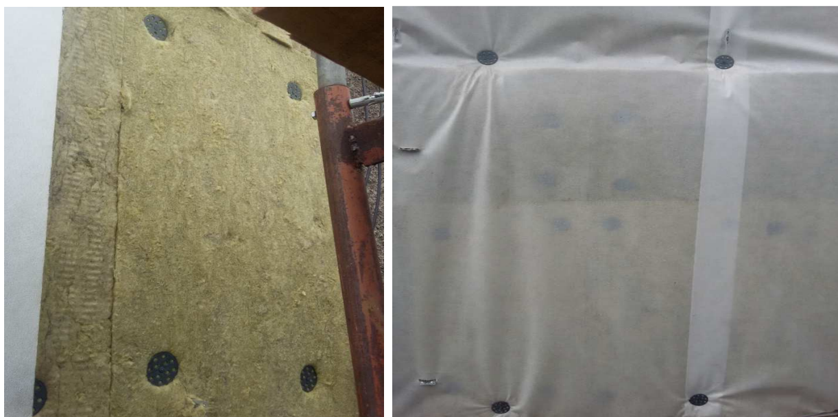
Рисунок 11 - Фрагмент утепления и смонтированной ветро-гидрозащитной пленки на стене фасада
