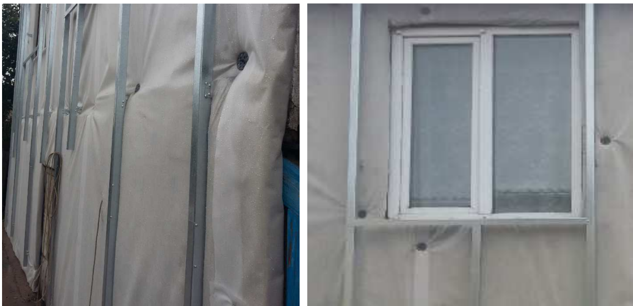
Рисунок 12 – Смонтированный вертикальный опорный профиль на стене фасада
