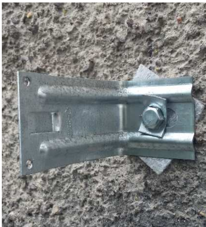
Рисунок 10 - Общий вид смонтированного кронштейна
