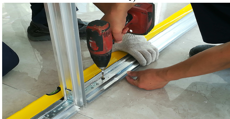
Рисунок 13 - Сборка перегородки из готовых каркасов (модулей)
