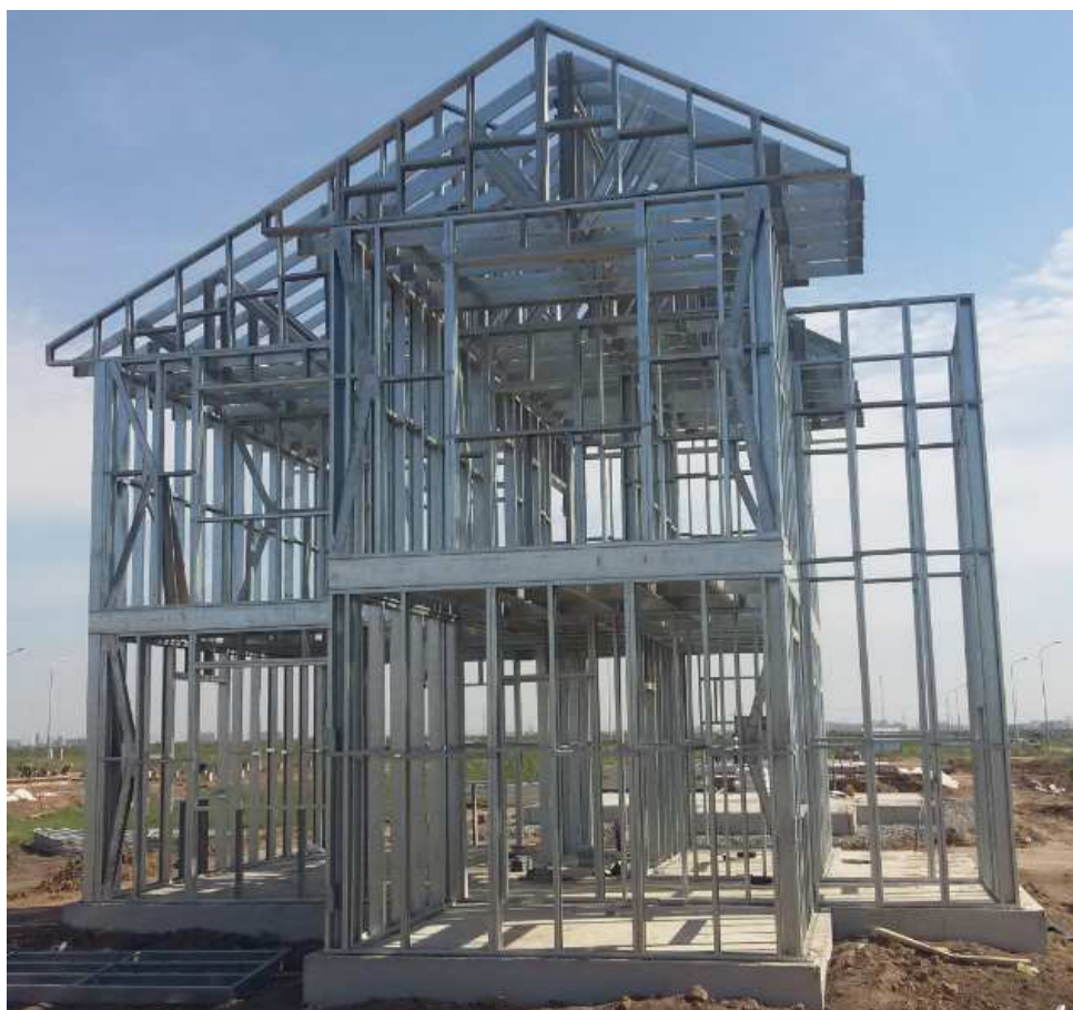
Рисунок 15 – Общий вид собранной кровли из ферм ЛСТК
