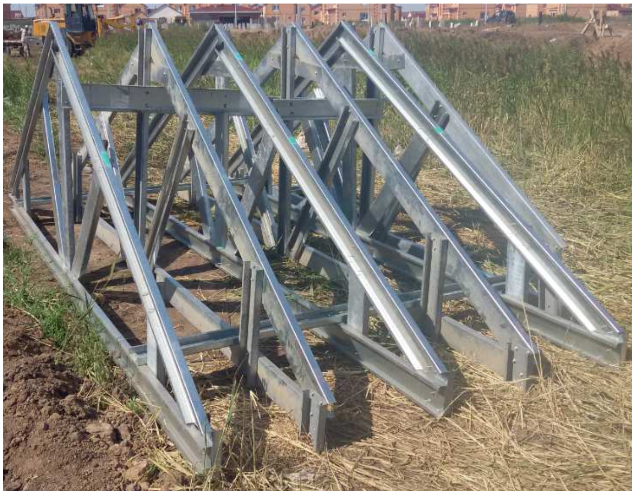
Рисунок 11 - Собранная группа ферм для монтажа
