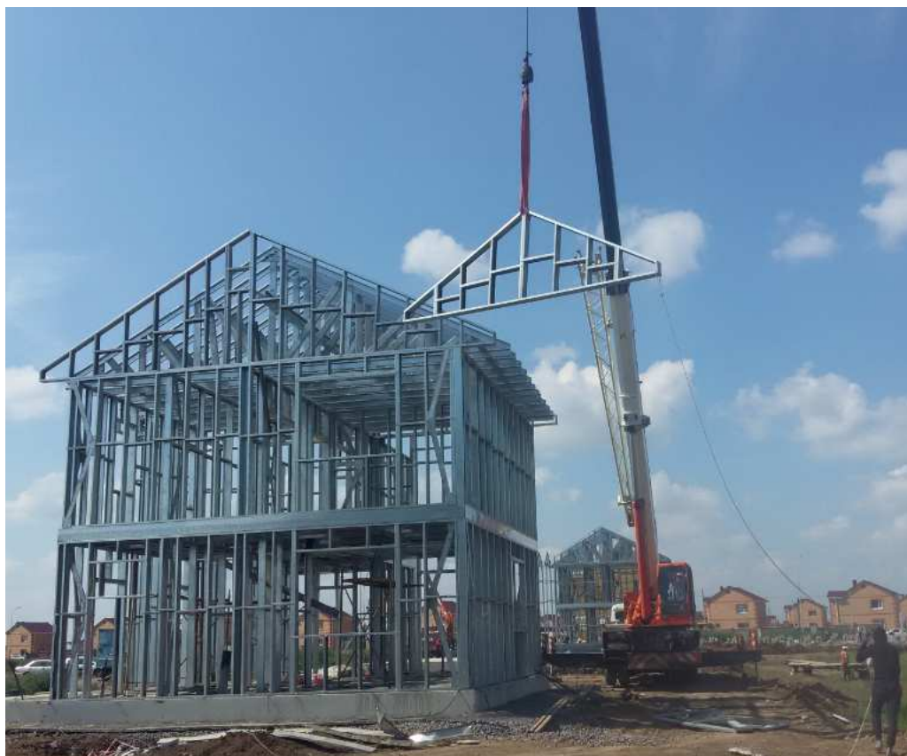
Рисунок 13 - Монтаж основных несущих ферм
