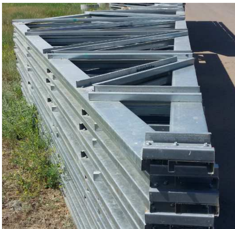
Рисунок 7 – Фермы складированные в штабель и готовые к монтажу
