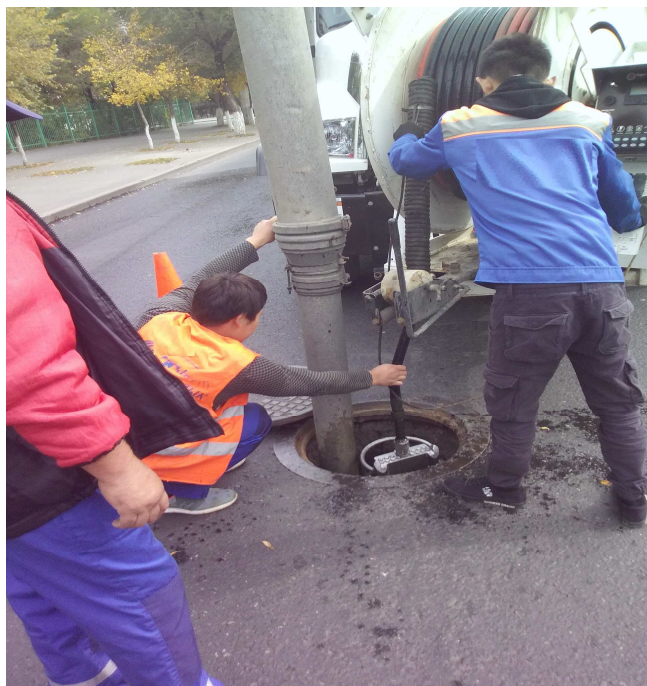
Рисунок 8 – Процесс заведение донной насадки в канализационный колодец
