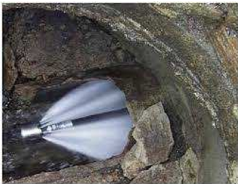
Рисунок 11 – Водяные струи высокого давления подающиеся под давлением через форсунки каналопромывочной насадки
