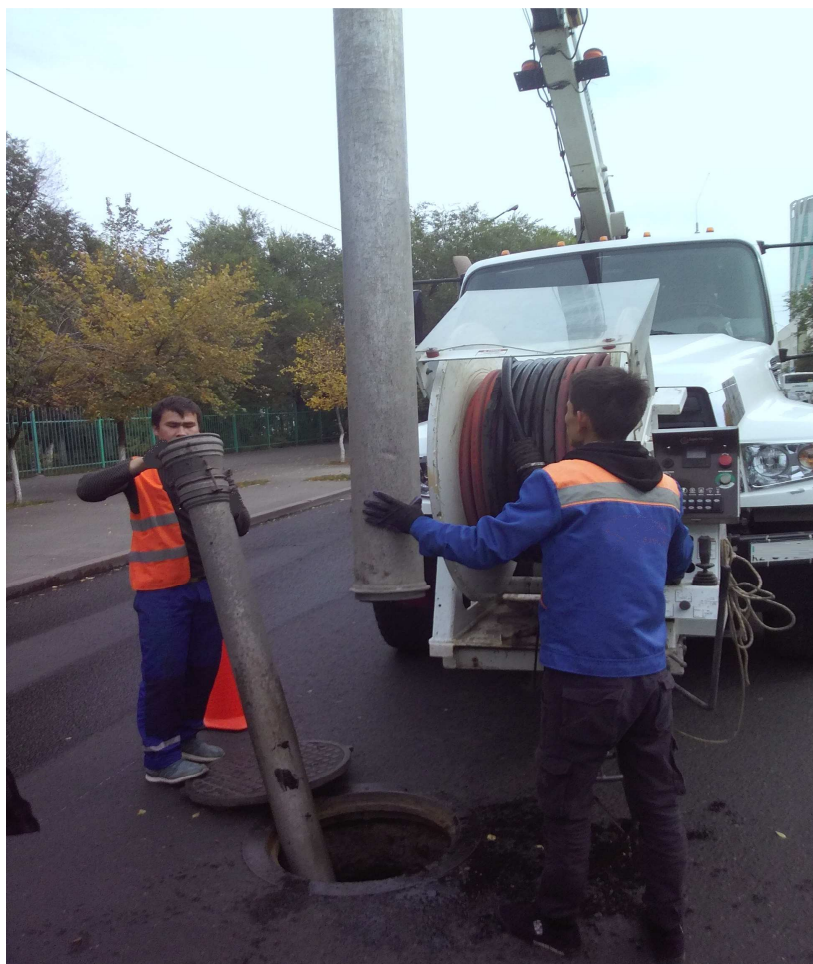
Рисунок 12 – Процесс удлинения или укорачивания вакуумной трубы
