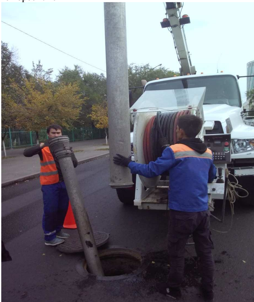
12-сурет - Вакуумды құбырдың ұзарту немесе қысқарту процесі
