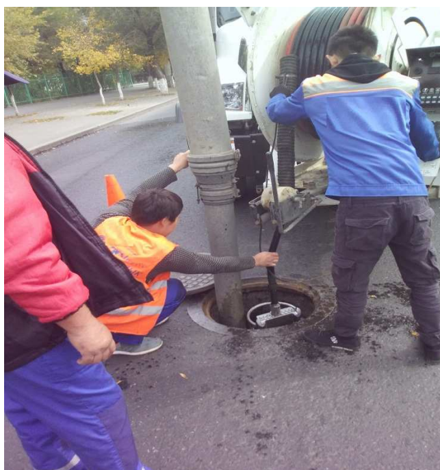
8-сурет – дондық саптаманы кәріз құдығына енгізу процесі
