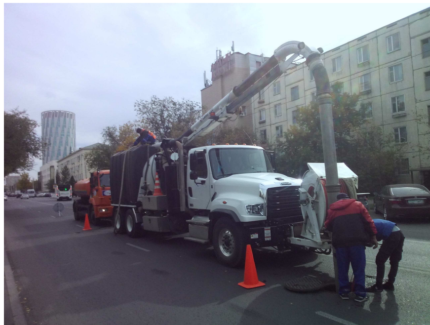
Рисунок – 10 Комбинированная гидродинамическая машина установленная у нижнего колодца прочищаемого участка
