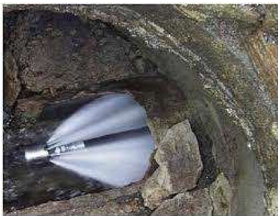
11-сурет – Арна жужу саптарының форсункаларынан жоғары қысыммен шығатын су шашырандылары
