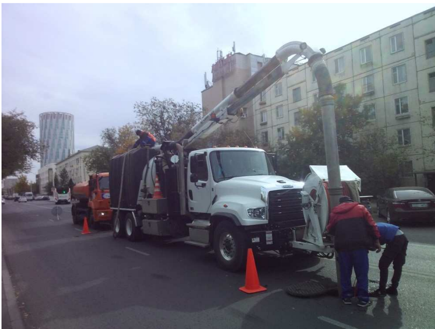
10-сурет тазартылатын учаскенің төменгі құдығына орнатылған біріктірілген гидродинамикалық машина
