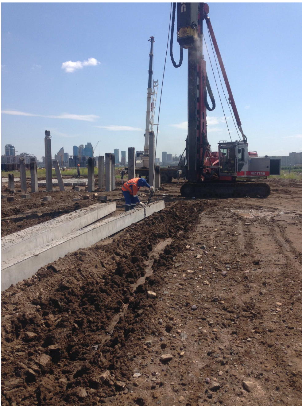
Рисунок 12 - Строповка сваи
