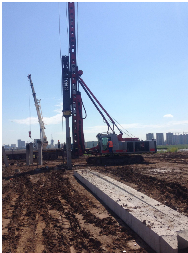
Рисунок 14 - Забивка свай
