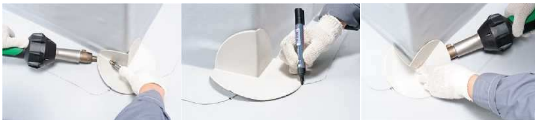
Рисунок 15 – Устройство наружного угла
