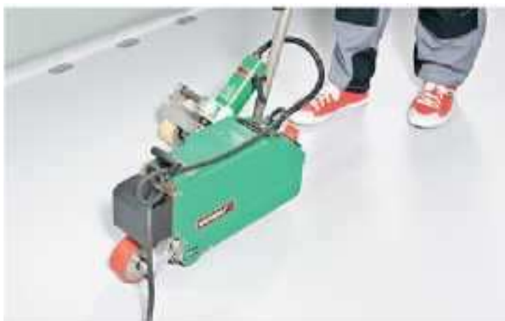
Рисунок 17 – Сварка полотен мембраны при помощи аппарата горячего воздуха
