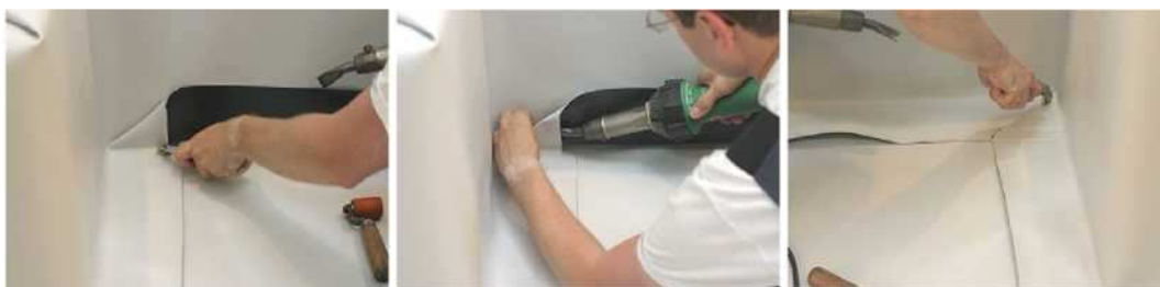
Рисунок 16 – Устройство внутреннего угла
