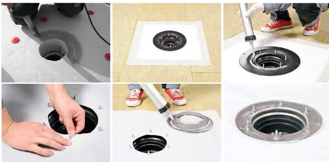
Рисунок 18 - Устройство примыкания мембраны к водоприемной воронке
