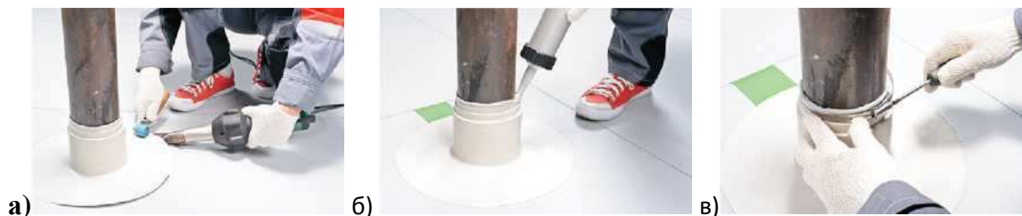
Рисунок 25 – Примыкание готового элемента к трубе
