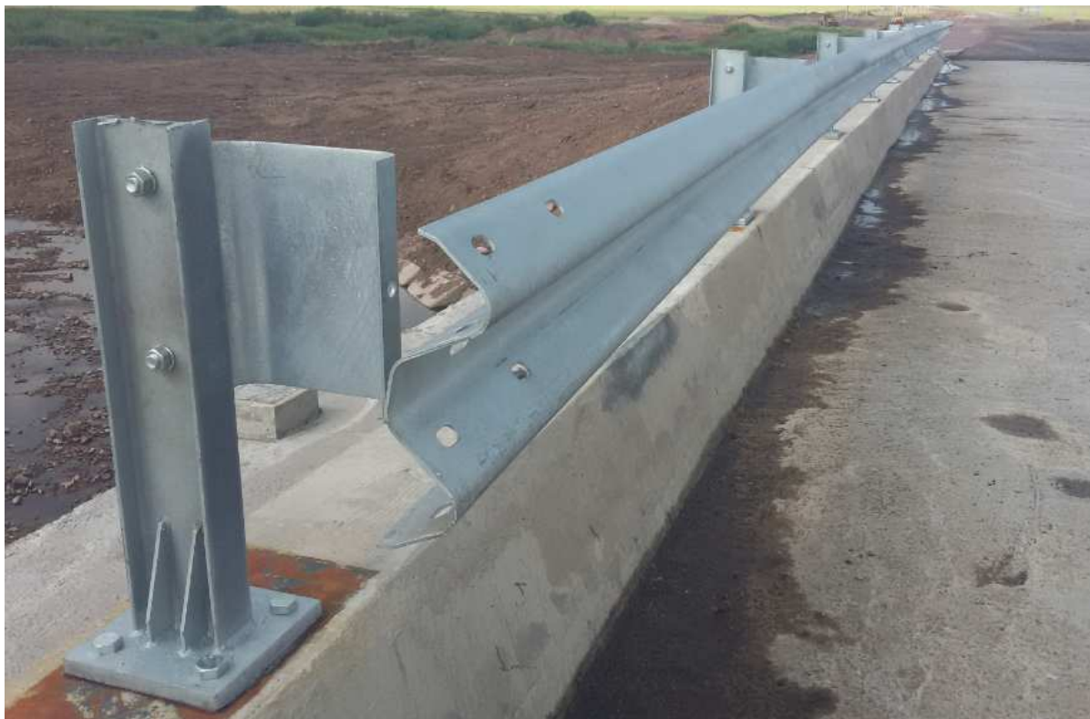
Рисунок 23 – Монтаж балки ограждения
