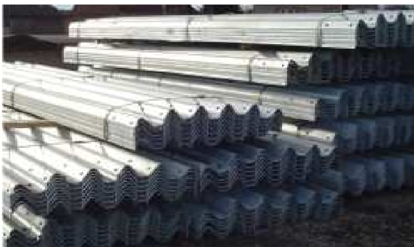
Рисунок 14 – Складирование балок барьерного ограждения
