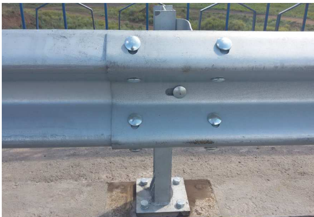
Рисунок 25 – Узел стыка балок барьерного ограждения одностороннего исполнения
