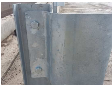
Рисунок 18 - Установка консолей - амортизаторов
