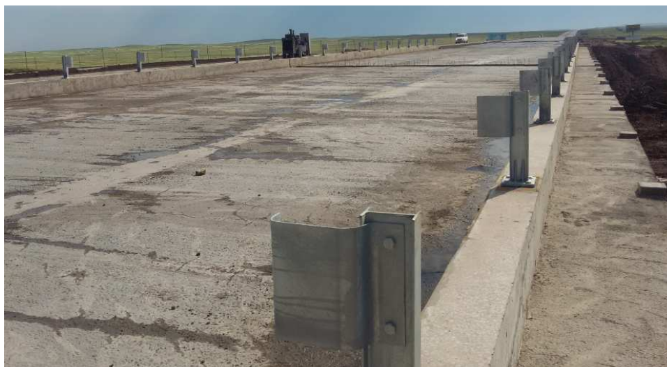
Рисунок 16 - Смонтированные стойки ограждения по краю моста
