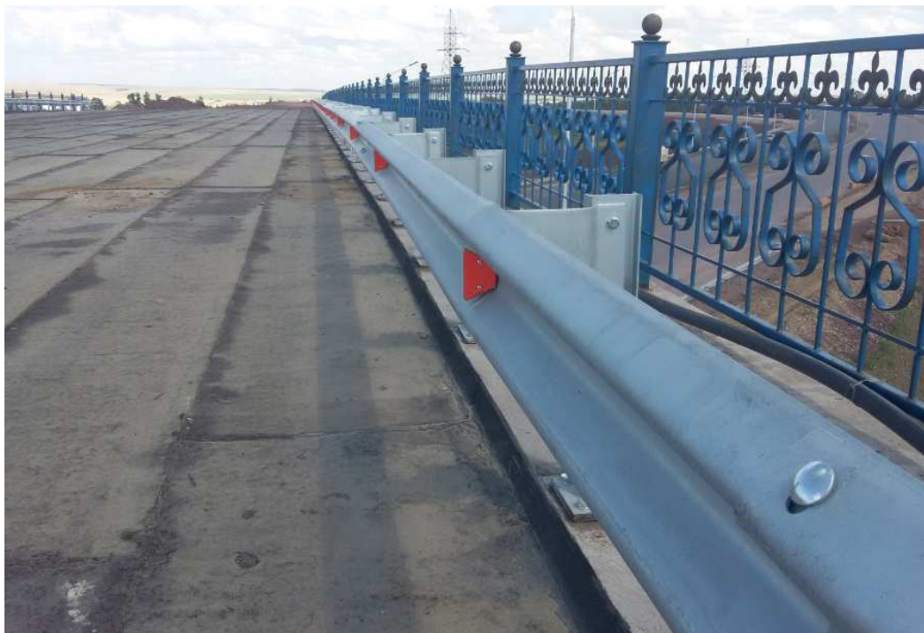
Рисунок 24 – Смонтированное барьерное ограждение одностороннего исполнения
