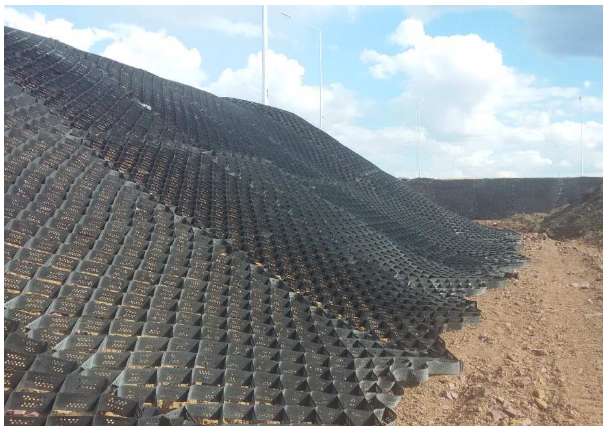
Рисунок 12 - Закрепление уложенной на откос георешетки анкерами
