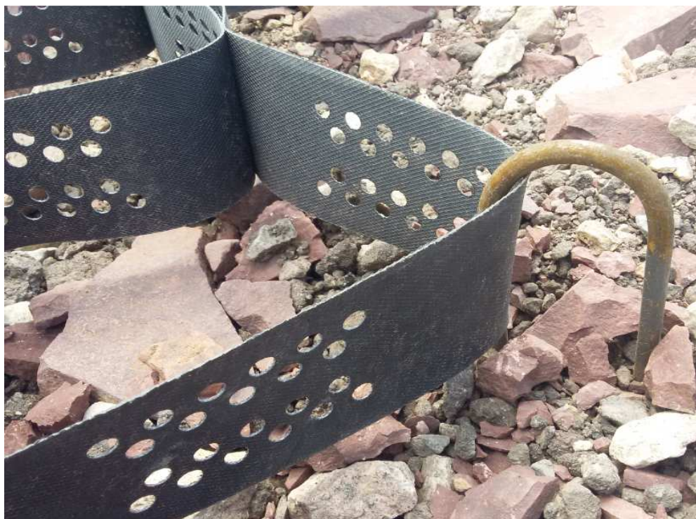
Рисунок 10 - Закрепление георешетки анкерами
