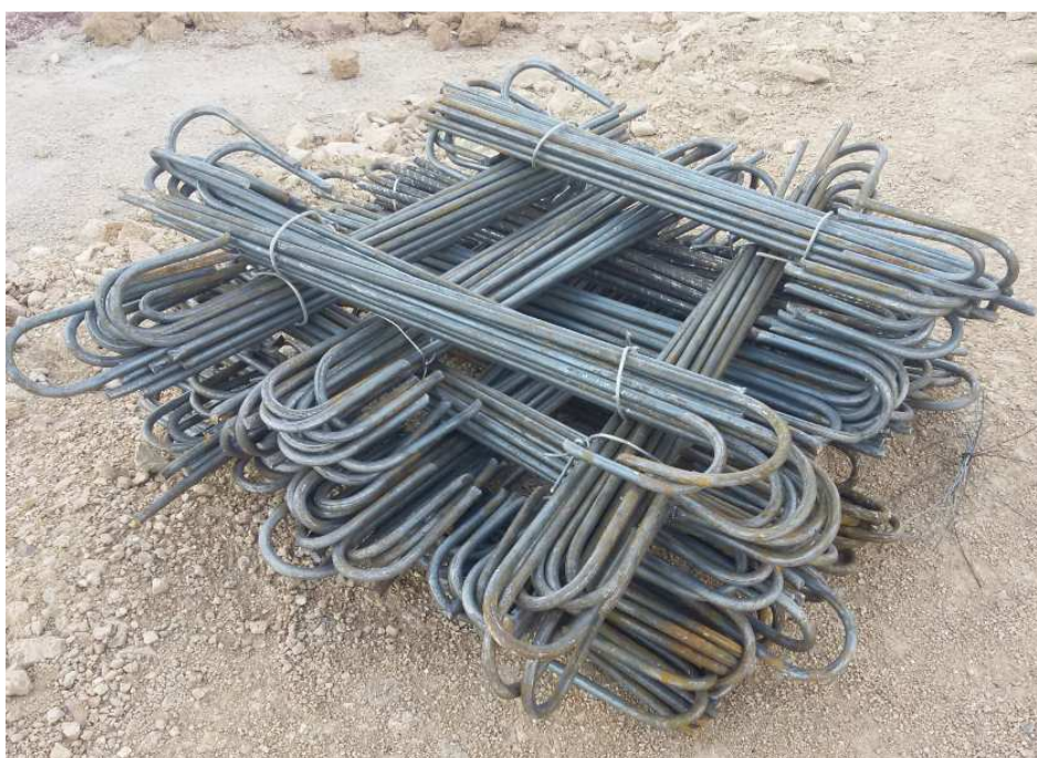
Рисунок 4 – Общий вид складирования монтажных анкеров
