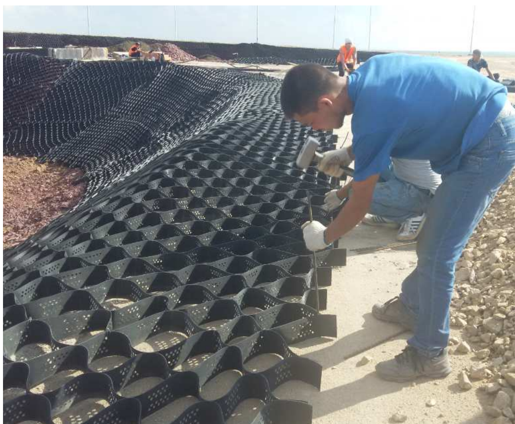
Рисунок 11 - Закрепление георешетки анкерами на бровке откоса
