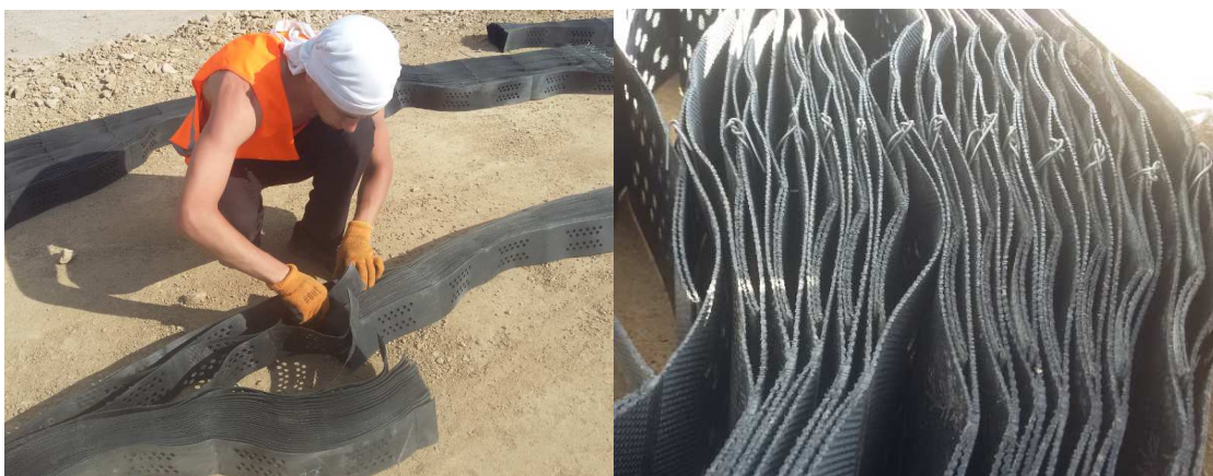
Рисунок 9 - Сшивание модулей георешетки
