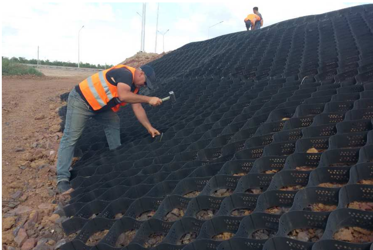
Рисунок 12 - Закрепление уложенной на откос георешетки анкерами
