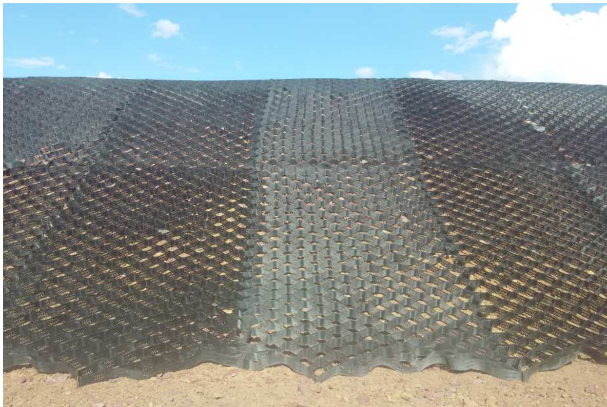
Рисунок 13 – Общий вид георешетки уложенной на откос
