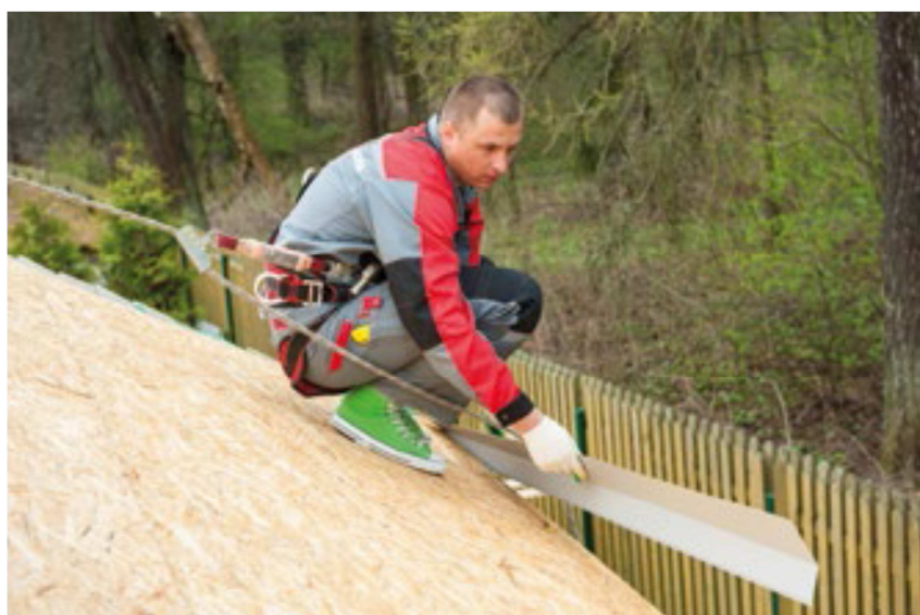
Рисунок 12 – Устройство усиление карнизного свеса
