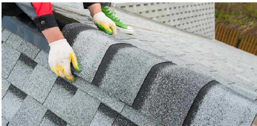
Рисунок 4 –Общий вид коньково-карнизной черепицы
