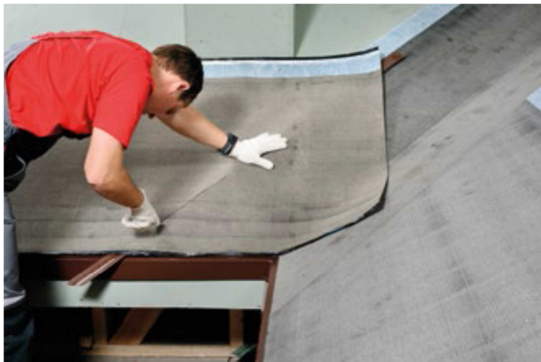
Рисунок 15 – Укладка самоклеящегося подкладочного материала на карнизном свесе
