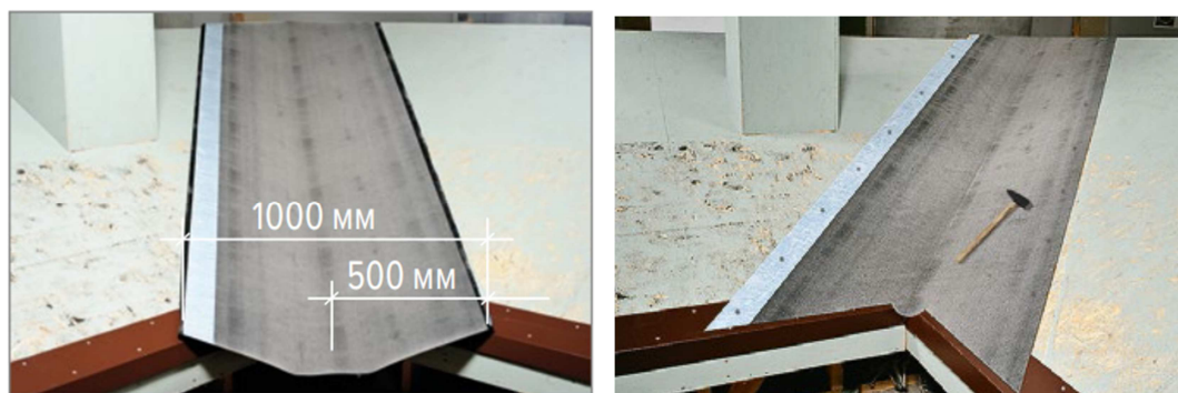
Рисунок 14 – Самоклеящийся подкладочный материал уложенный в ендове
