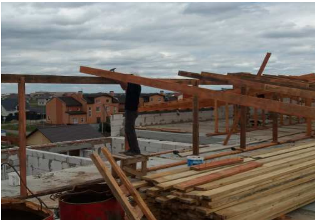
Рисунок 9 – Установка стропильных ног
