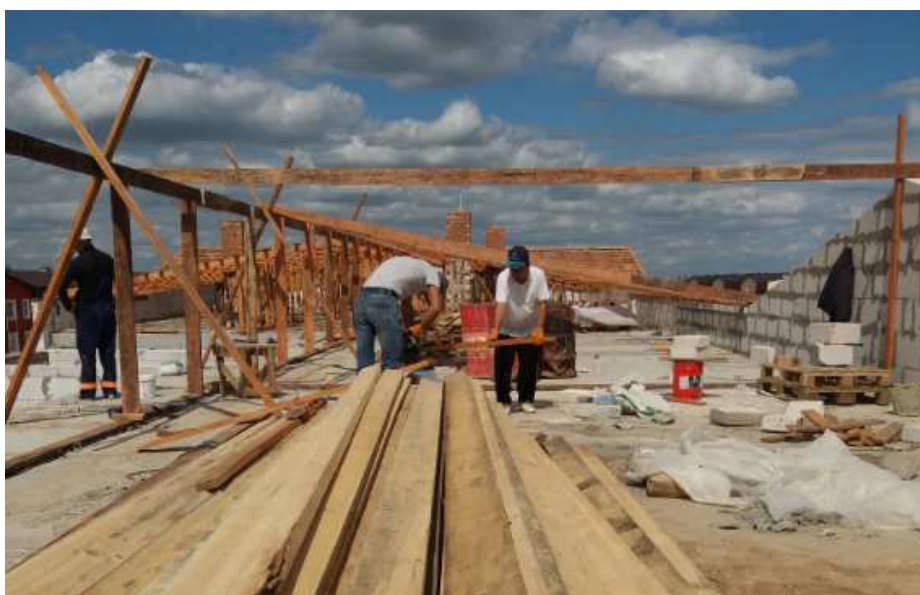
Рисунок 8 – Установка стоек и коньковых прогонов
