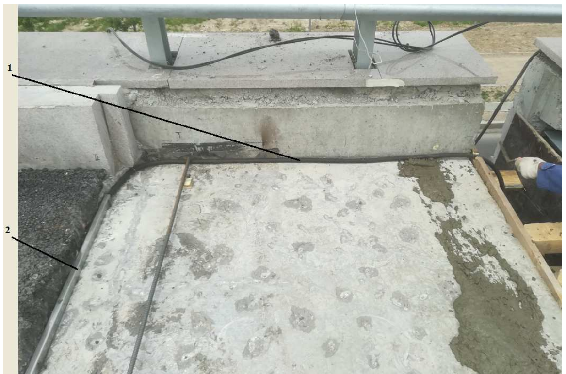
Рисунок 20 – Устройство дренажного канала
