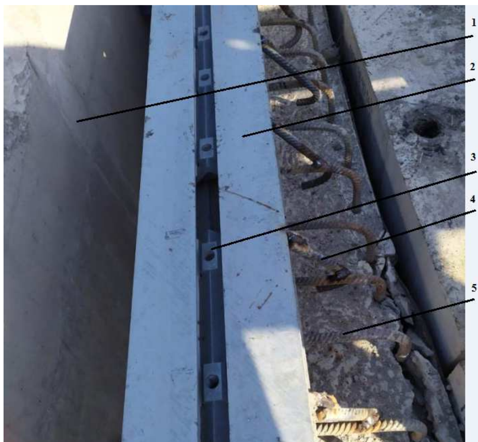
Рисунок 18 – Выставленная по проектным отметкам поперечная стальная направляющая
