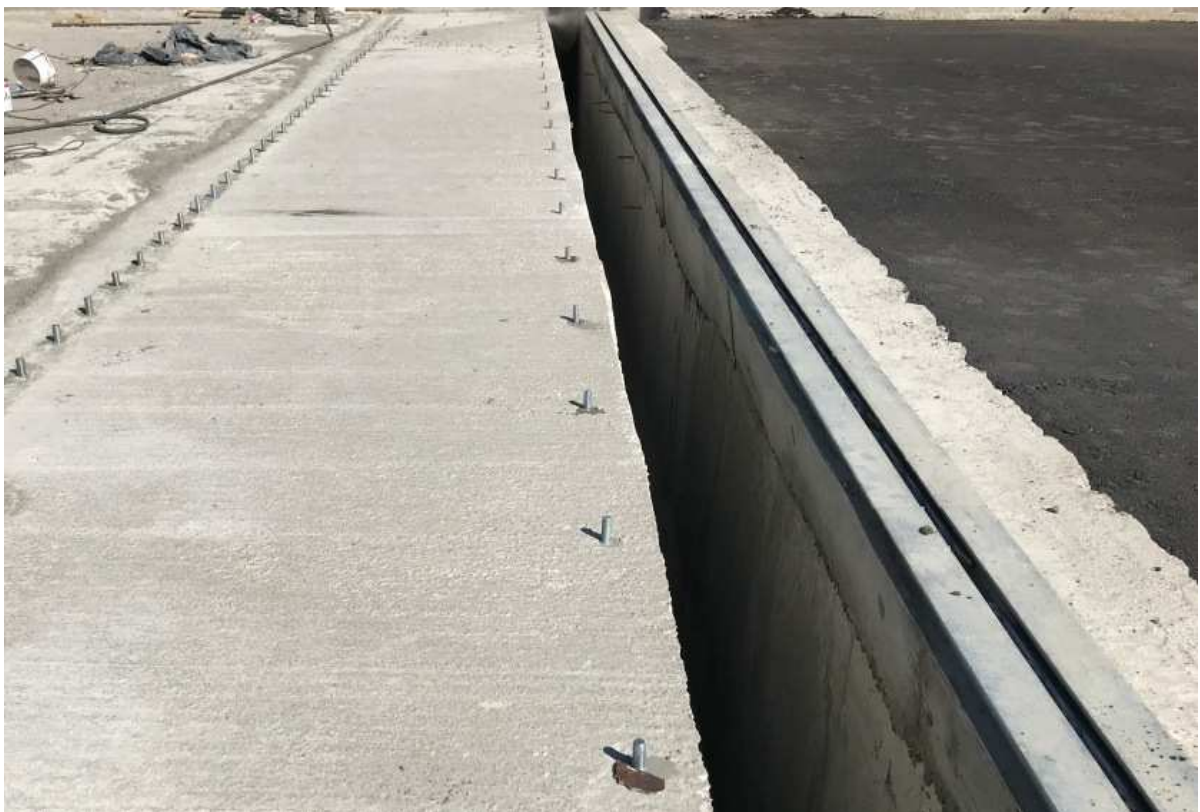
Рисунок 23 – Работы по сверлению отверстий и установке анкерных шпилек а – установка металлического шаблона, б – сверление разметочных отверстий по шаблону, в – сверление до проектной глубины и продувка готовых отверстий сжатым воздухом, г – приготовление двухкомпонентного клей герметика и заполнение отверстий, д – установленные анкерные шпильки
