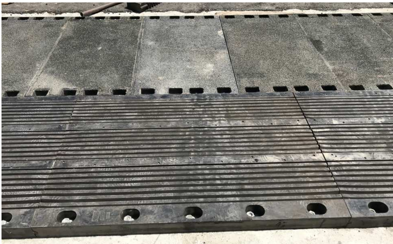
Рисунок 1 - Общий вид резинометаллических модулей деформационного шва типа «FIP INDUSTRIALE»
