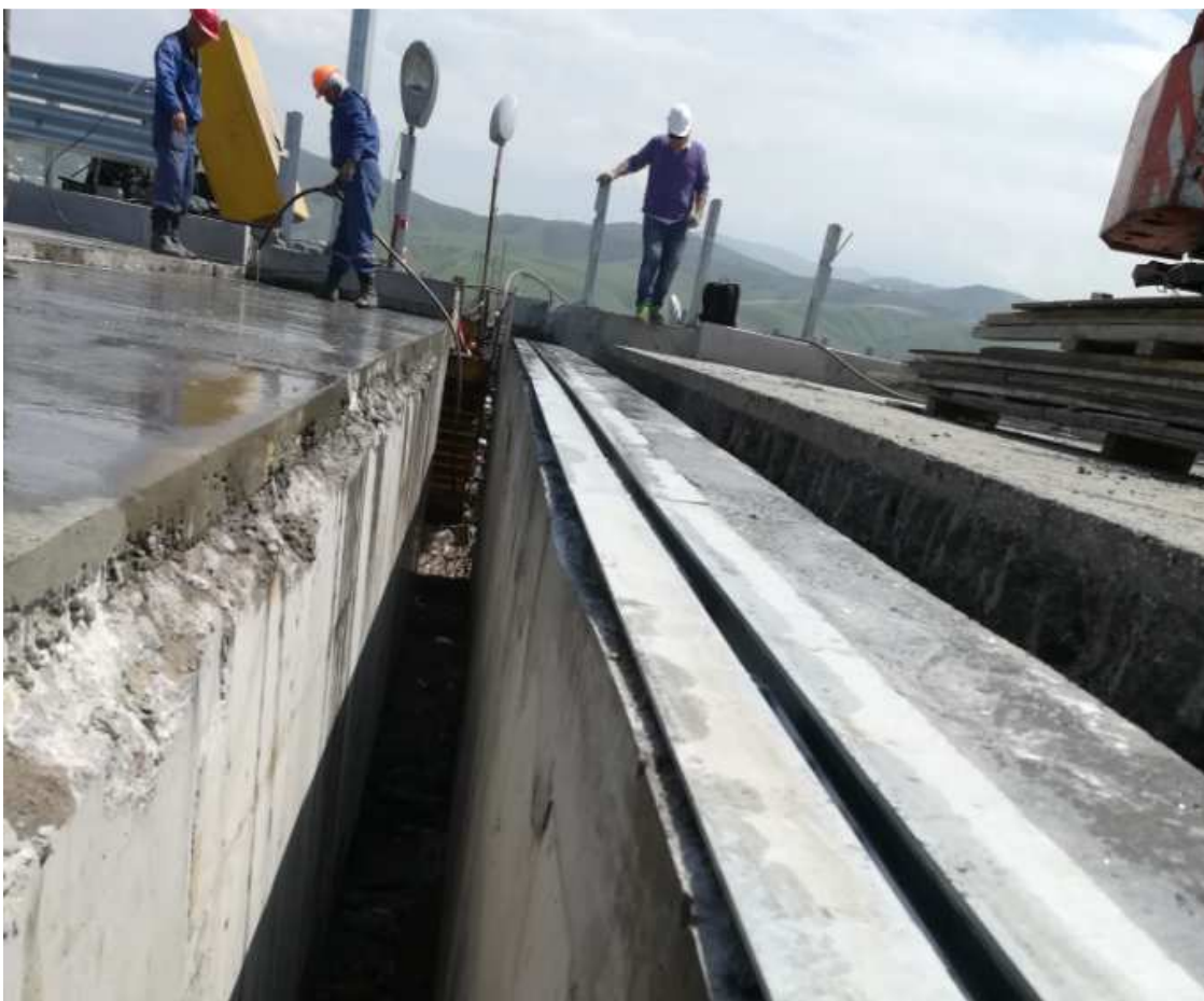
Рисунок 22 – Уложенная бетонная смесь
