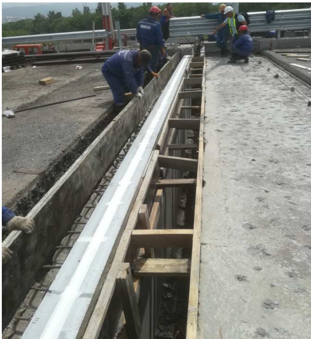
Рисунок 19 - Устройство опалубки
