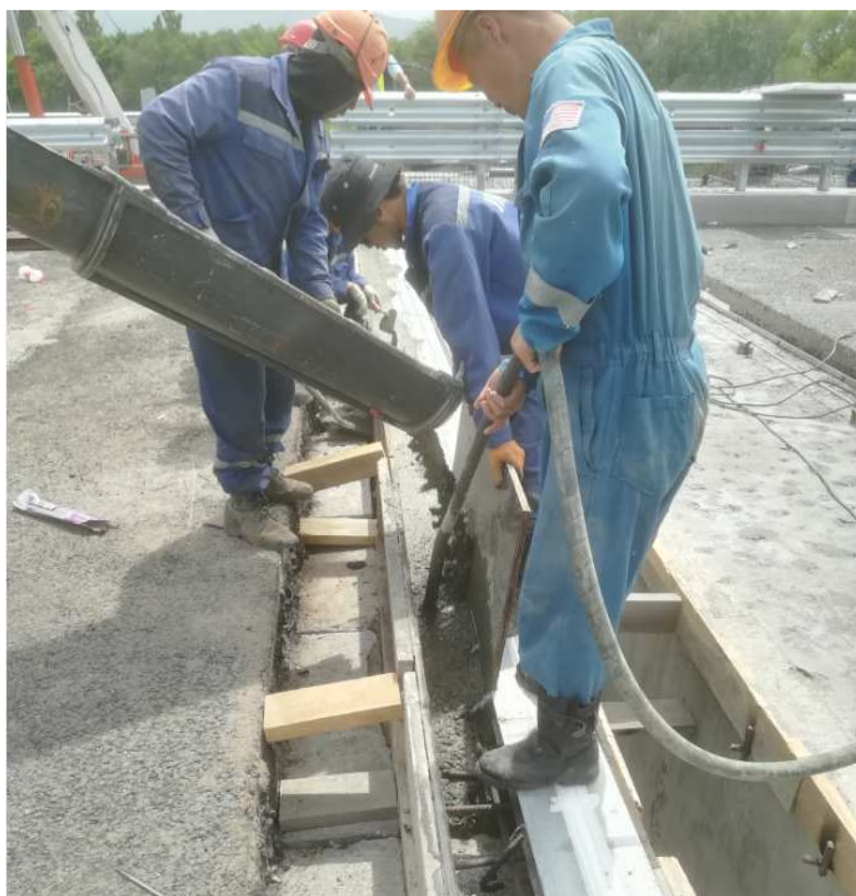
Рисунок 21 – Прием и укладка бетонной смеси
