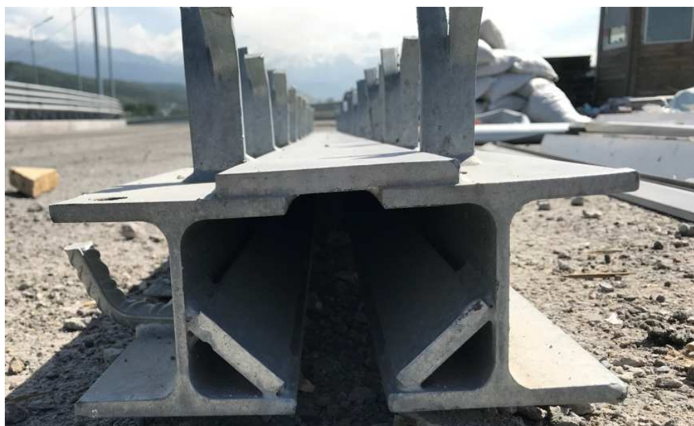
Рисунок 2 - Общий вид поперечной стальной направляющей
