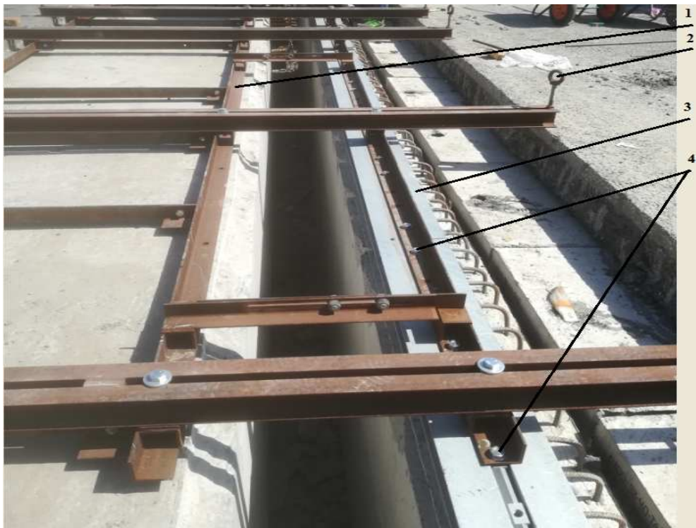
Рисунок 16 - Выставление поперечной направляющей в проектное положение при помощи шаблона
