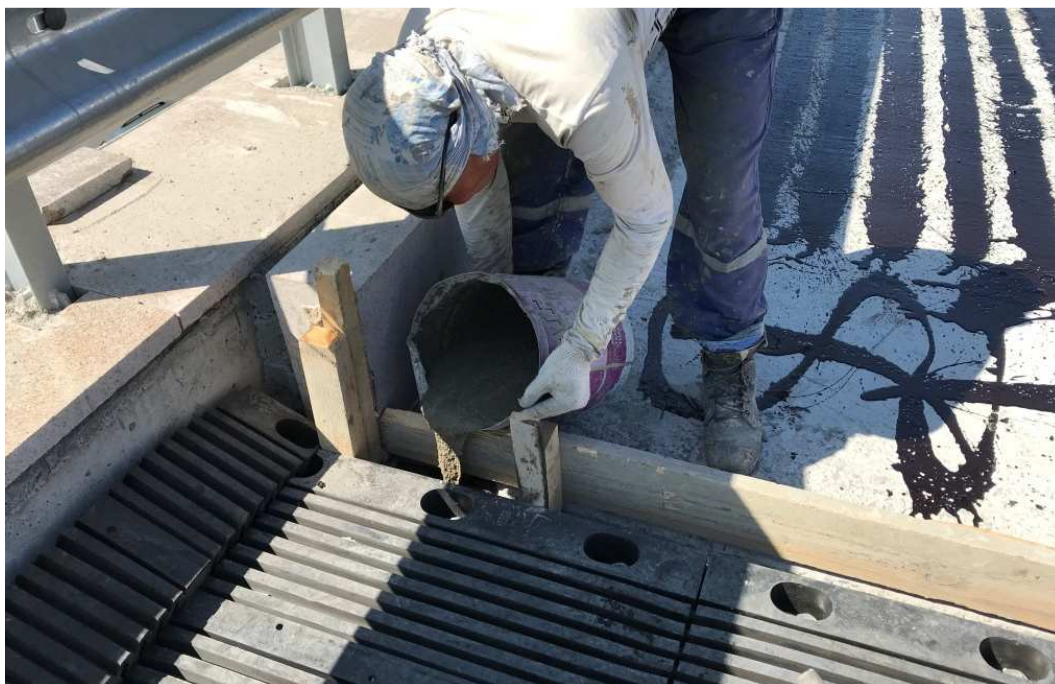
Рисунок 28 – Работы по бетонированию бровок деформационного шва
