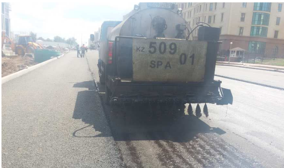
Рисунок 6 - Обработка основания битумной эмульсией
