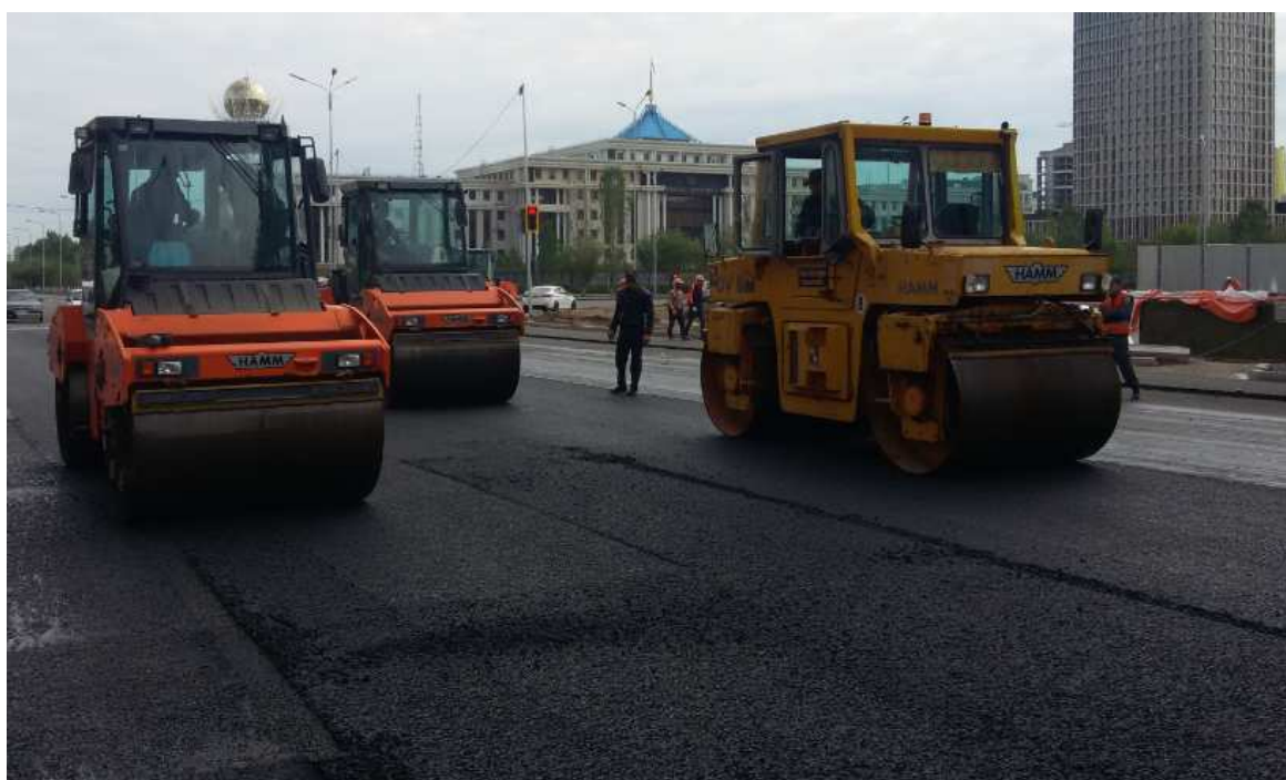
Рисунок 16 – Уплотнение уложенного щебеночно-мастичного асфальтобетона
