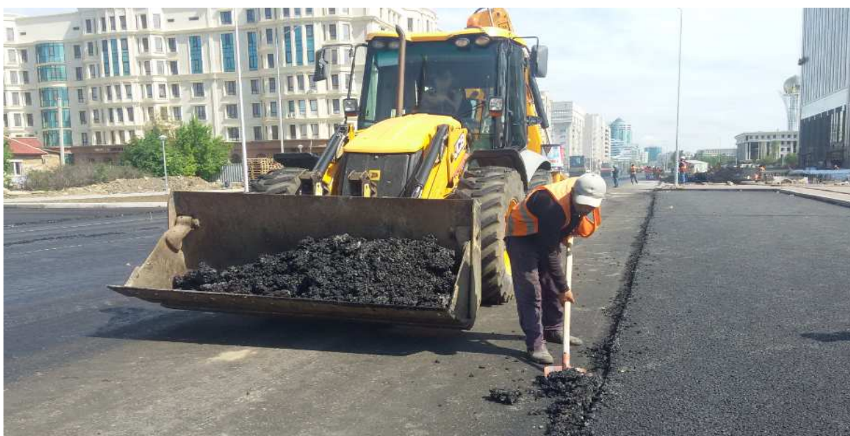
Рисунок 14 – Уборка срезанного асфальтобетона продольного рабочего шва
