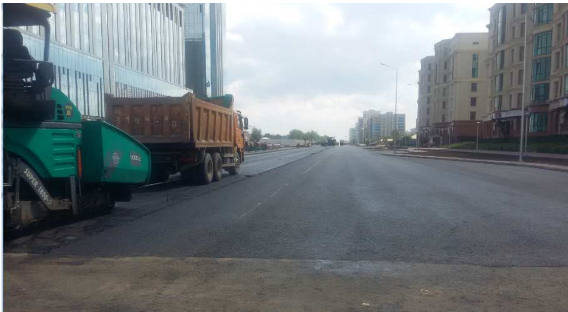
Рисунок 15 – Уложенный щебеночно-мастичный асфальтобетон одной полосы движения автотранспорта
