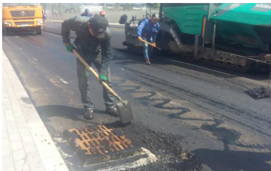
Рисунок 11 – Ручная доработка при укладке асфальтобетона
