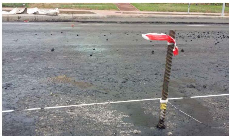
Рисунок 4 - Копирные струны со стойками
