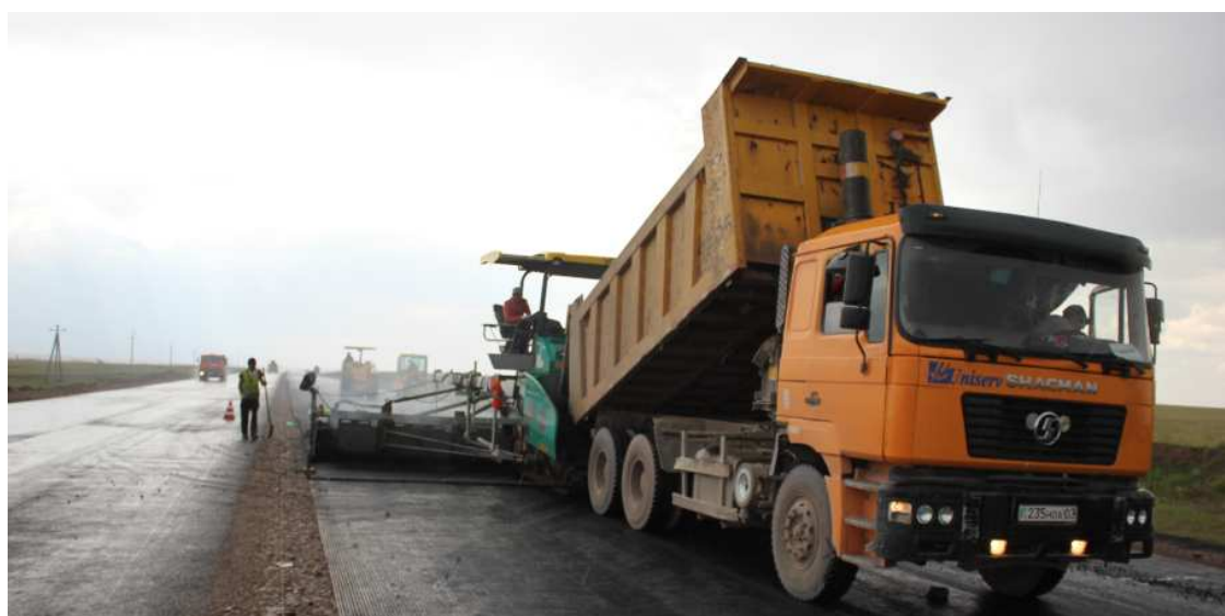
Рисунок 7 – Укладка щебеночно-мастичного асфальтобетона (ЩМА)
