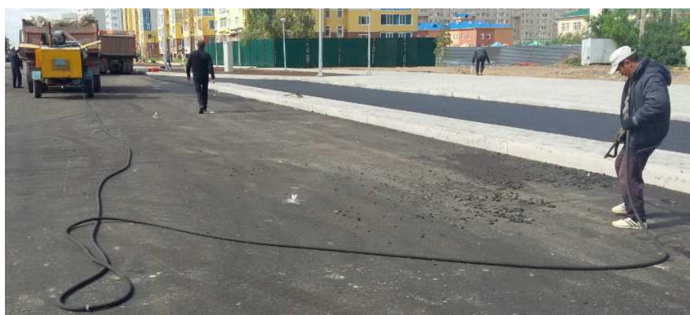
Рисунок 5 - Продувка сжатым воздухом основания под щебеночно-мастичный асфальтобетон (ЩМА)
