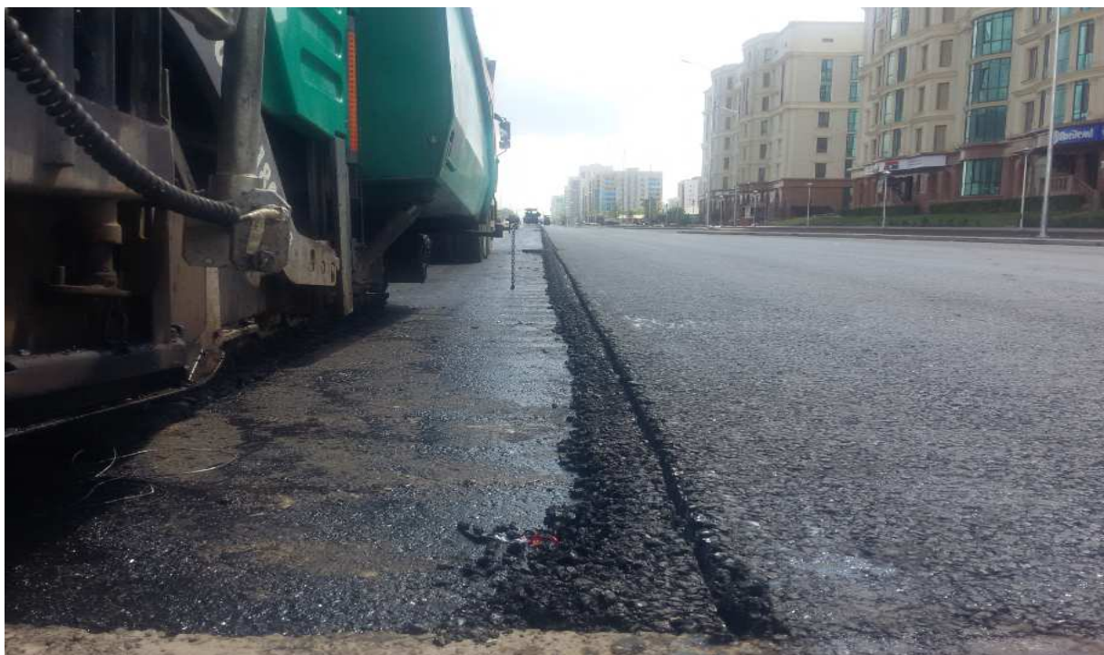
Рисунок 13 – Продольный рабочий шов
