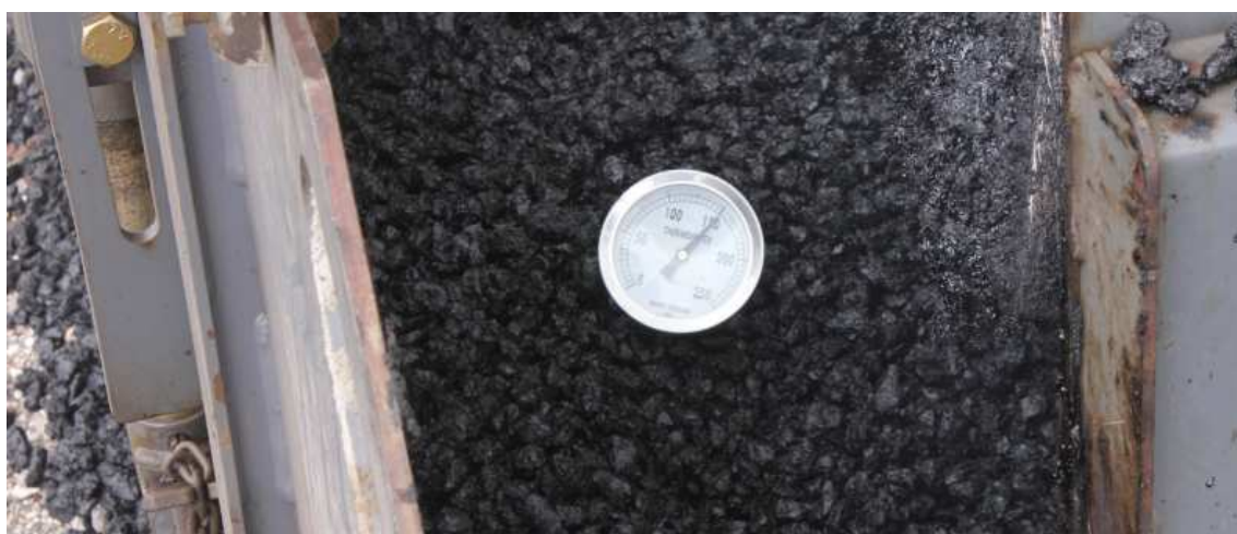
Рисунок 8 – Замер температуры ЩМА в процессе укладки
