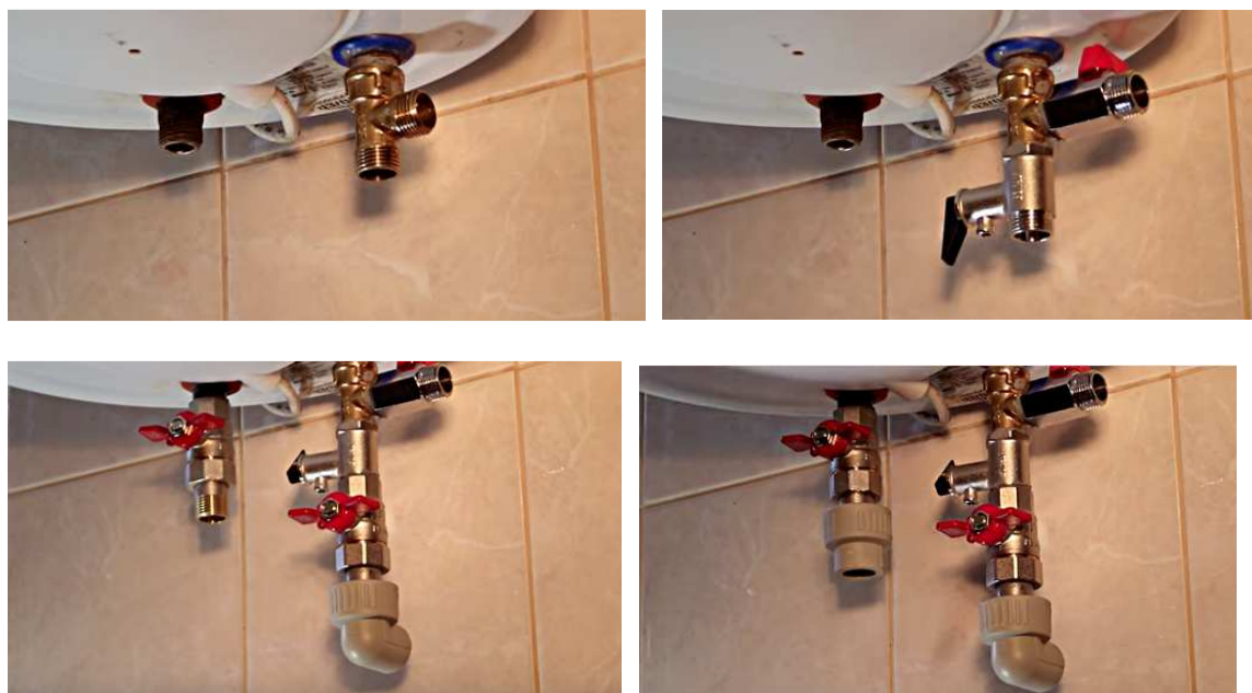
Рисунок 9 - Порядок соединения водонагревателя (емкостного)
