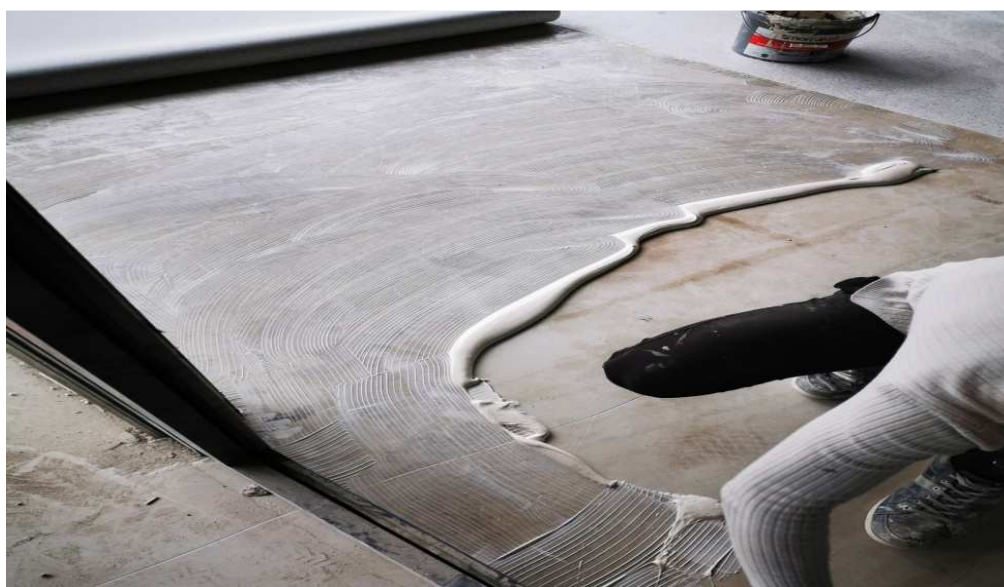
Рисунок 6 - Нанесение клеевого раствора
