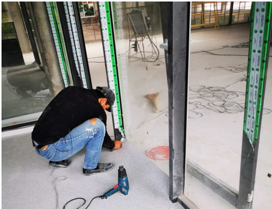
Рисунок 9 - Прирезка кромок линолеума
