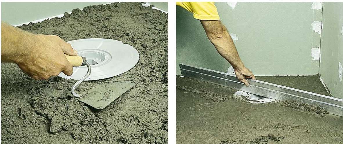
Рисунок 20 - Разравнивание свежеложенного раствора
