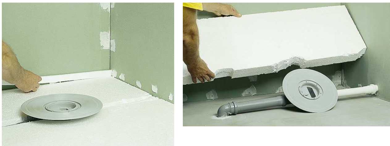
Рисунок 19 - Укладка теплоизоляции
