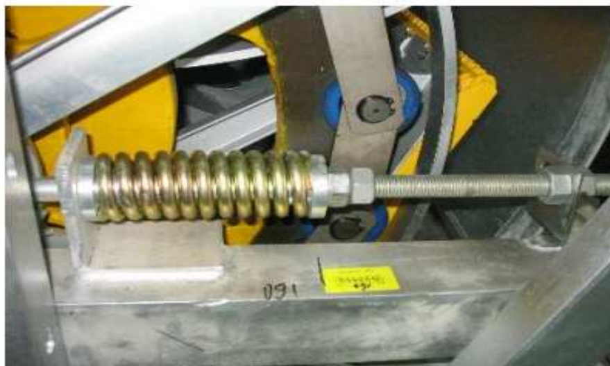
Рисунок 25 – Натяжение цепи для ступенек
