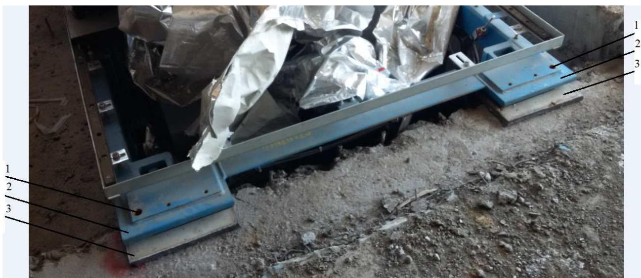
Рисунок 20 – Опорные части прямка и эскалатора
