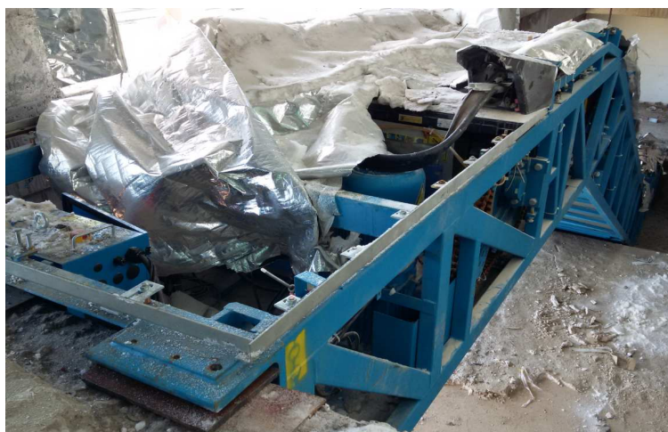
Рисунок 23 – Смонтированный эскалатор высотой подъема до 3,75м
