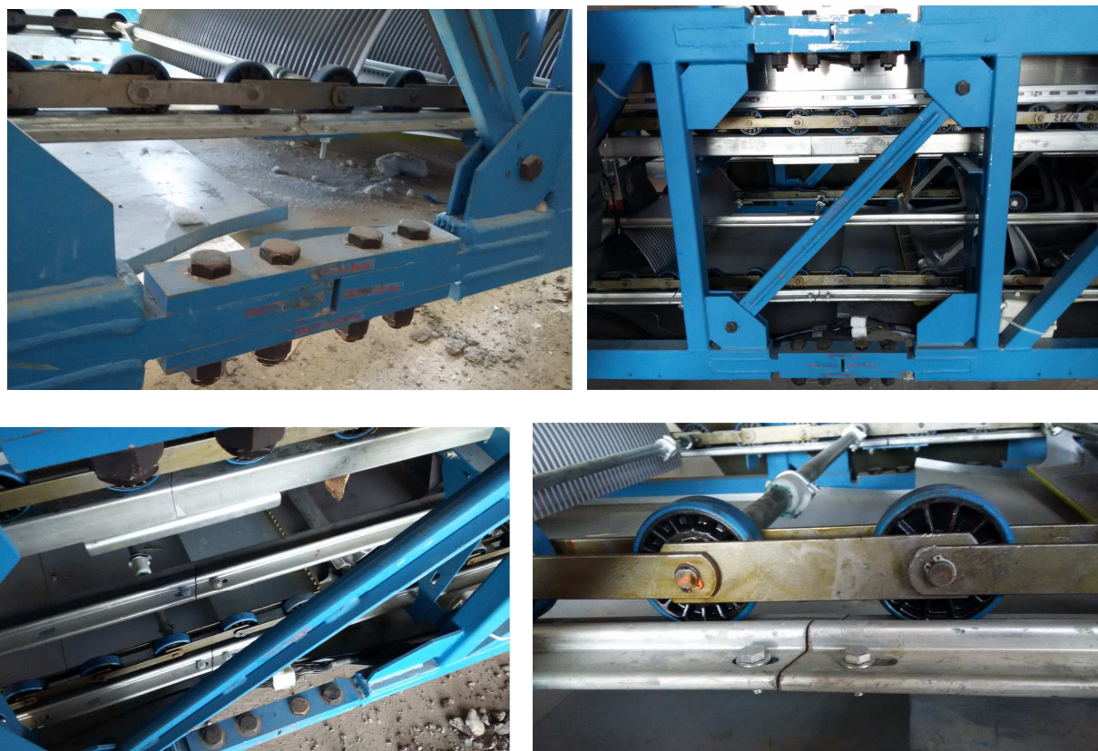
Рисунок 16 – Стыки соединения направляющих лестничного полотна и направляющих роликов ступеней
