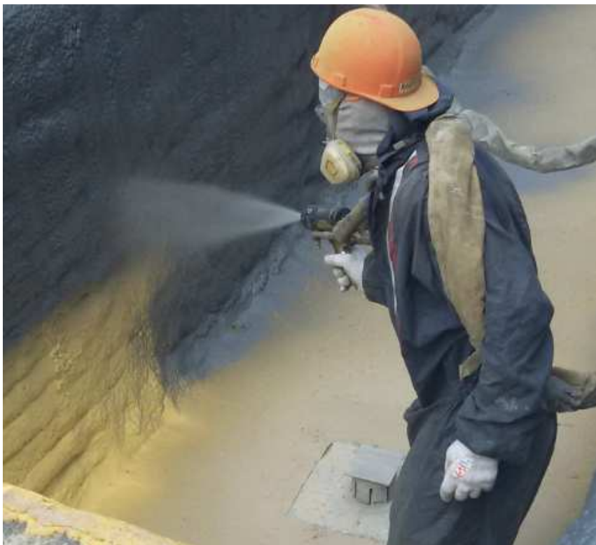
Рисунок 17 – Нанесение защитного слоя от ультрафиолетовых лучей полимочевиной
