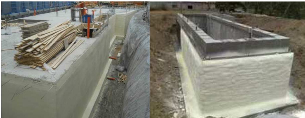
Рисунок 9 – Общий вид теплоизоляции подземных частей зданий
