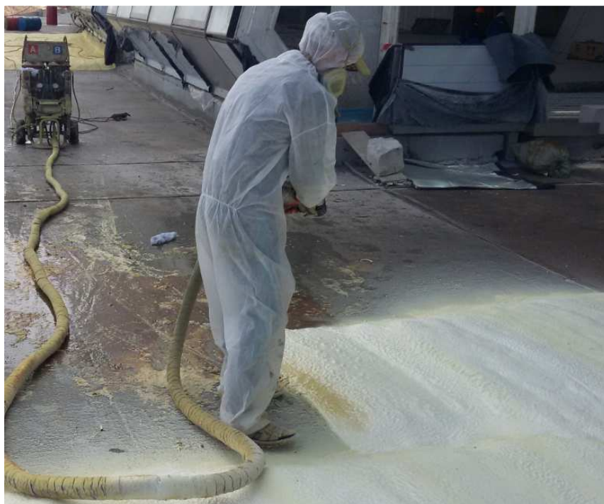
Рисунок 15 - Нанесение пенополиуретана на бетонное основание
