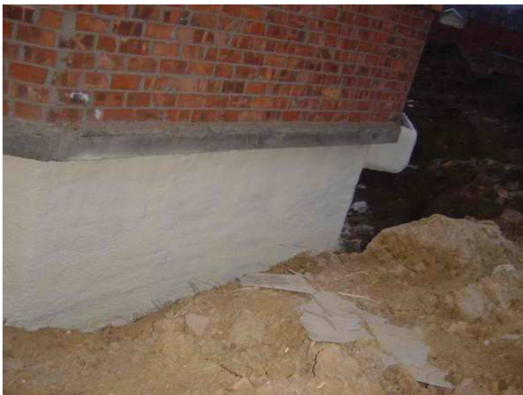
Рисунок 14 - Общий вид нанесенной теплоизоляции на фундамент здания
