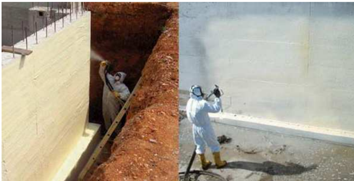
Рисунок 13 - Нанесение пенополиуретана на гидроизолированную бетонную поверхность
