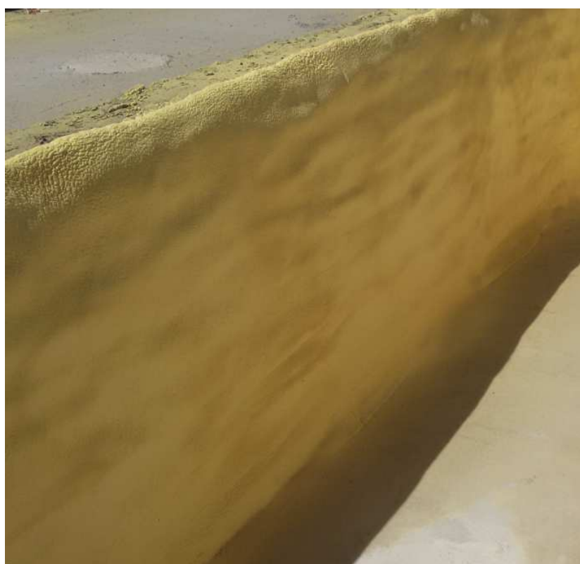
Рисунок 16 – Общий вид теплоизоляции пенополиуретаном фундаментной части здания
