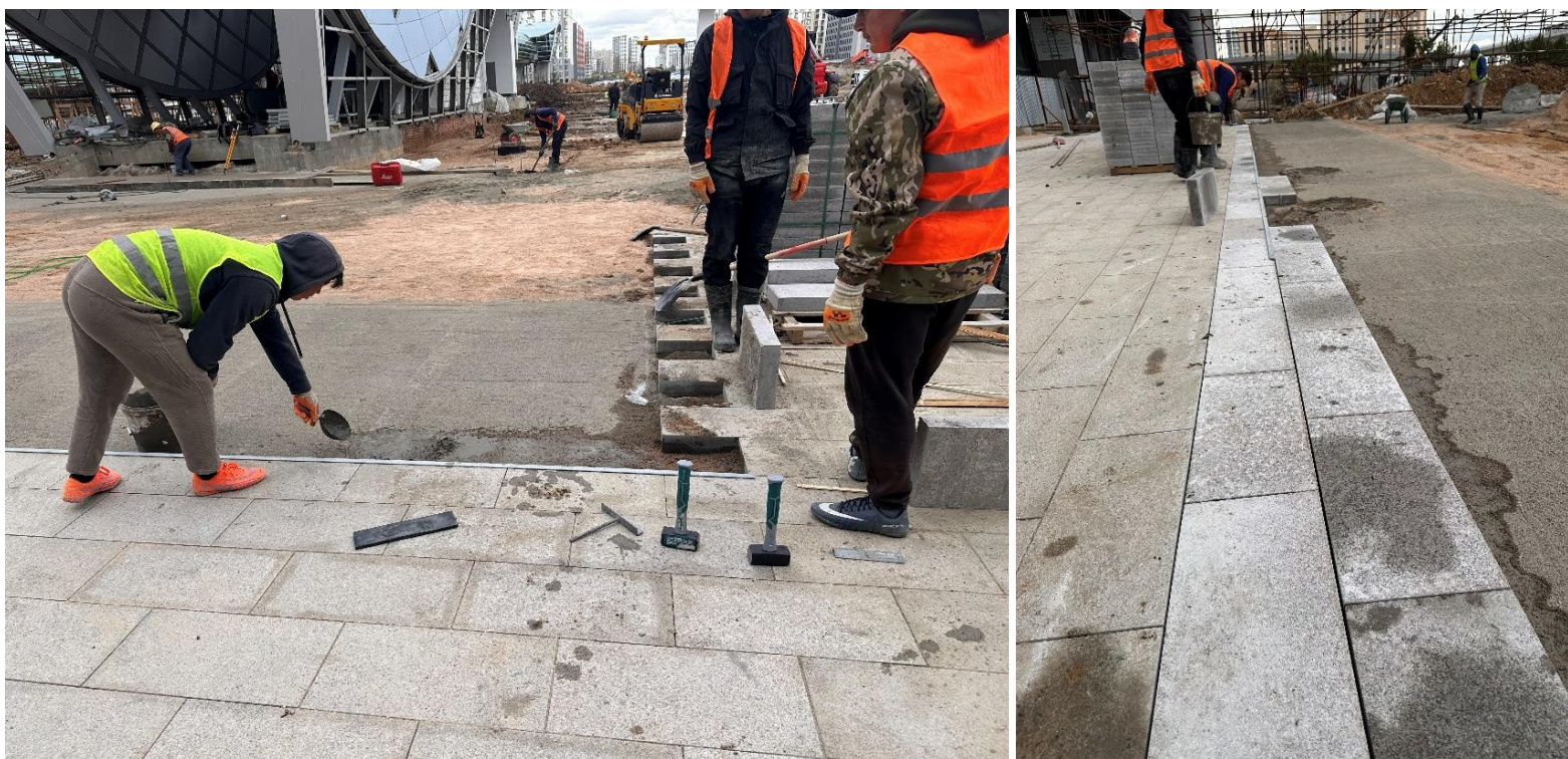
Рисунок 4 - Укладка гранитных плит
